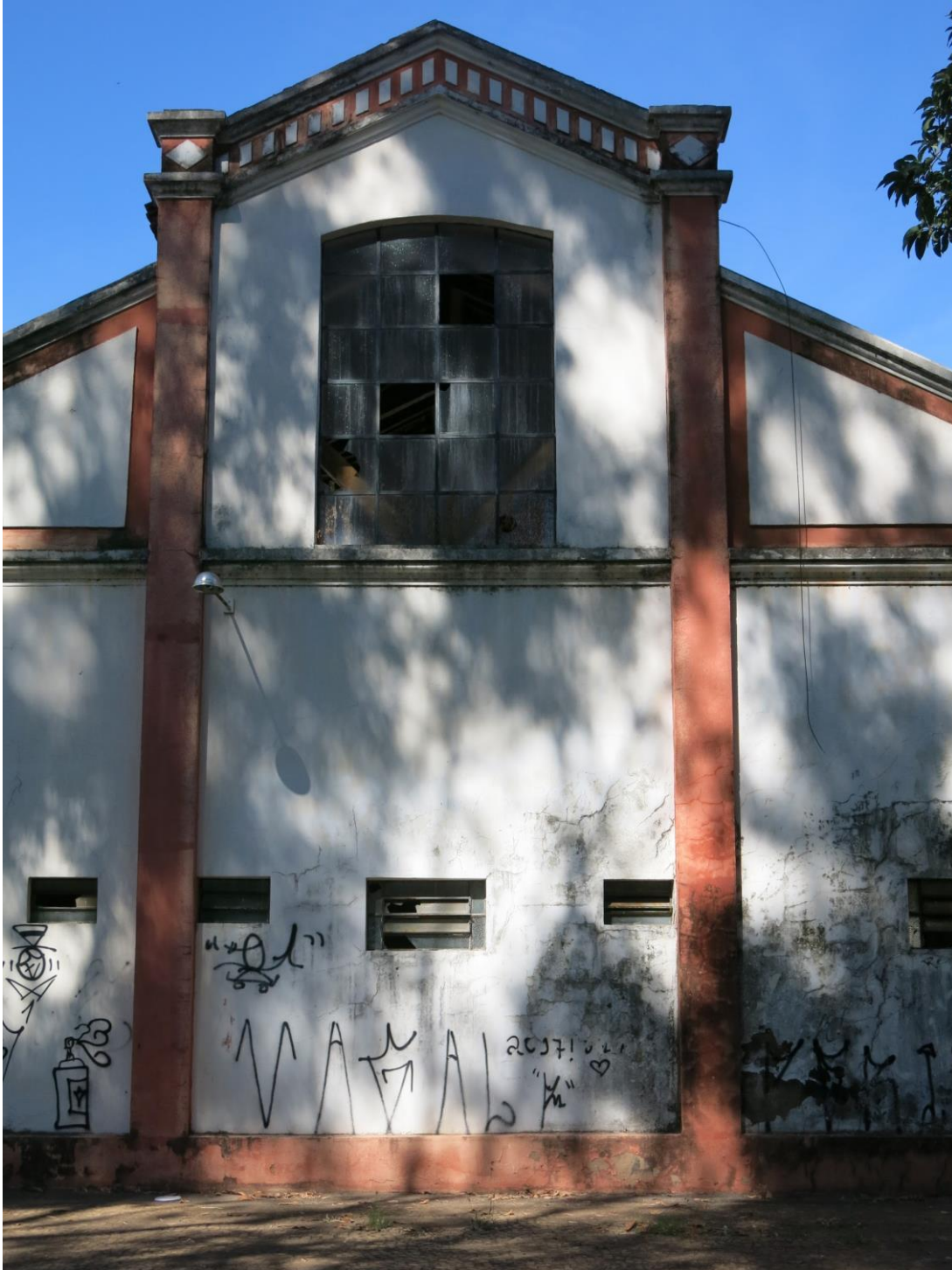
Figura 10 Depósito de Locomotivas de Araçatuba - Aberturas na fachada posterior. Fonte: Instituto Pedra
