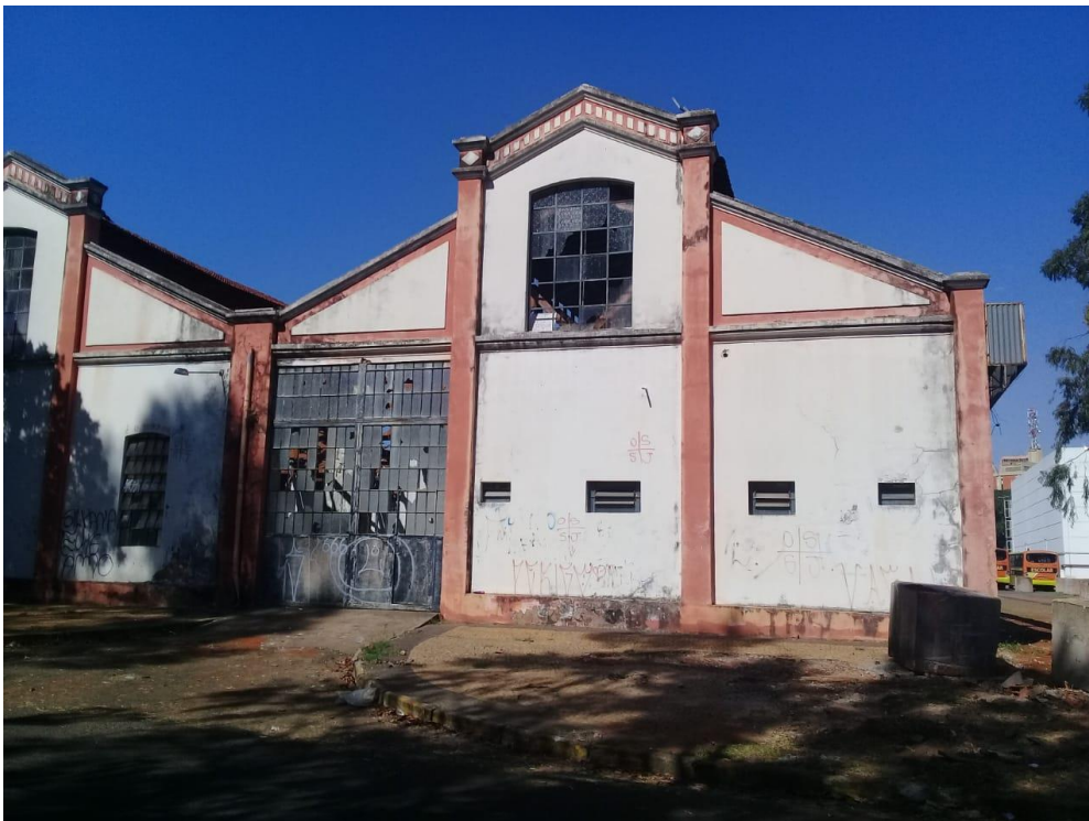
Figura 7 Depósito de Locomotivas de Araçatuba - Fachada posterior. Fonte: Instituto Pedra
