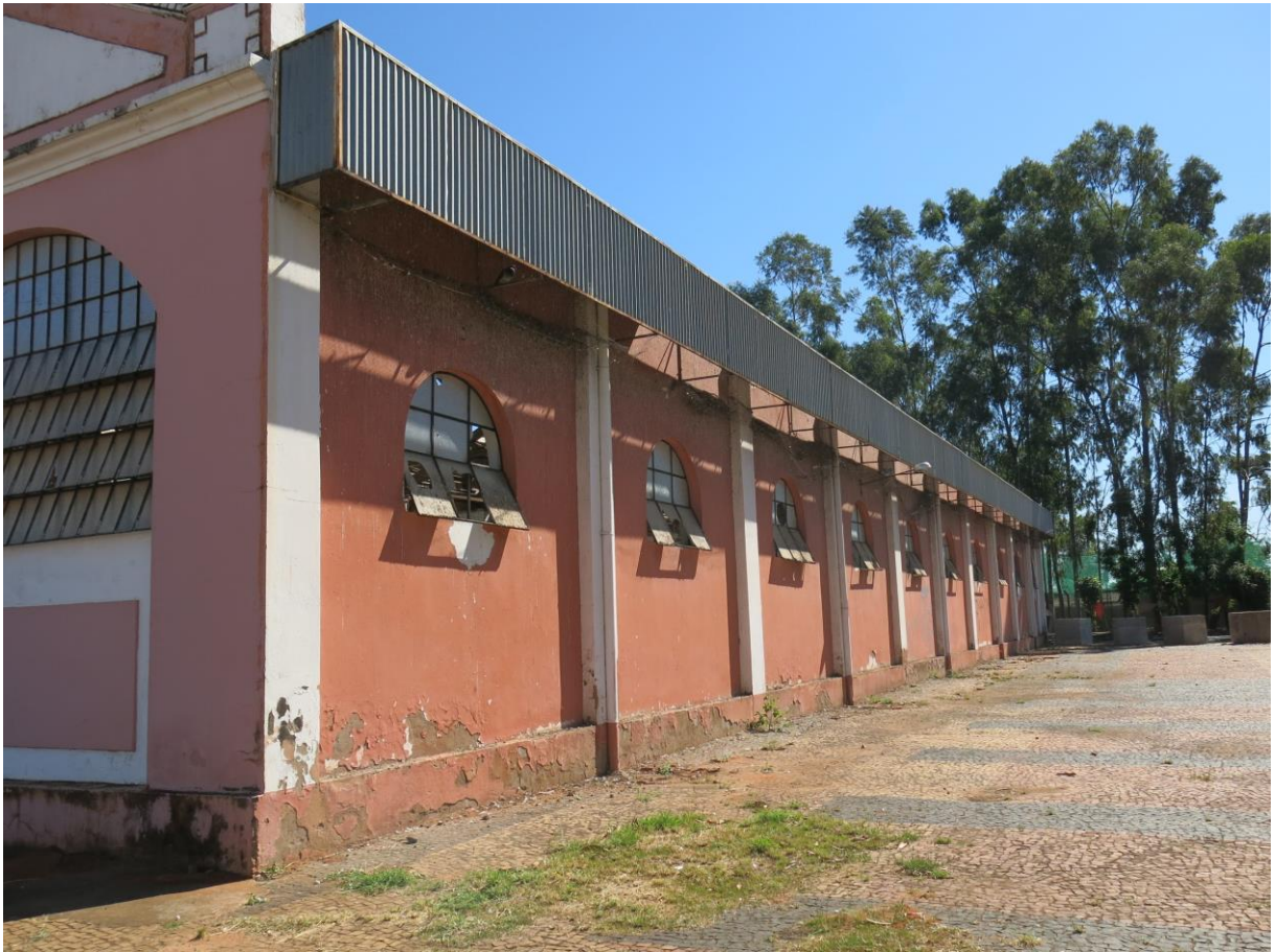
Figura 14 Depósito de Locomotivas de Araçatuba - Intervenção em fachada lateral. Fonte: Instituto Pedra
