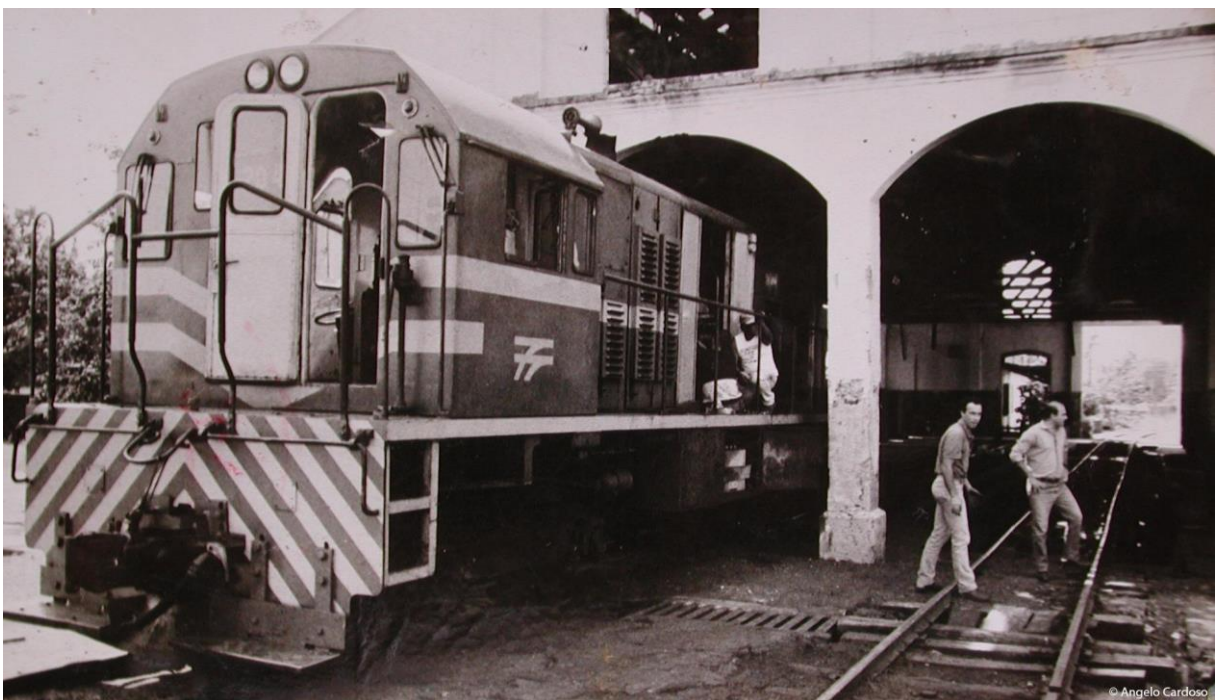
Figura 8 Depósito de Locomotivas de Araçatuba - Aberturas frontais. Fonte: Câmara Municipal de Araçatuba
