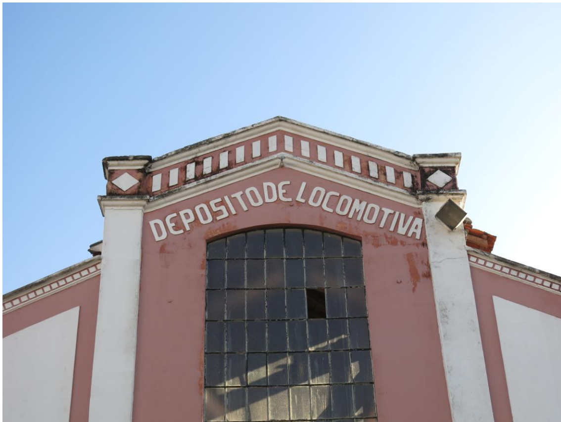
Figura 17 Depósito de Locomotivas de Araçatuba - Inscrição frontal (ala Central). Fonte: Instituto Pedra
