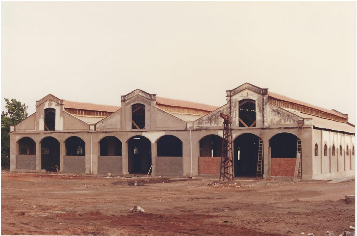
Figura 11 Depósito de Locomotivas de Araçatuba - Fechamento dos vãos frontais. Fonte: Museu Ferroviário “Moisés Joaquim Rodrigues”
