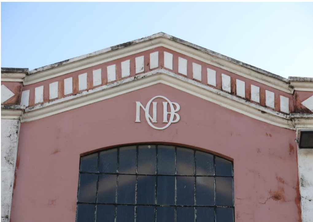
Figura 16 Depósito de Locomotivas de Araçatuba - Logotipo NOB (ala Oeste). Fonte: Instituto Pedra
