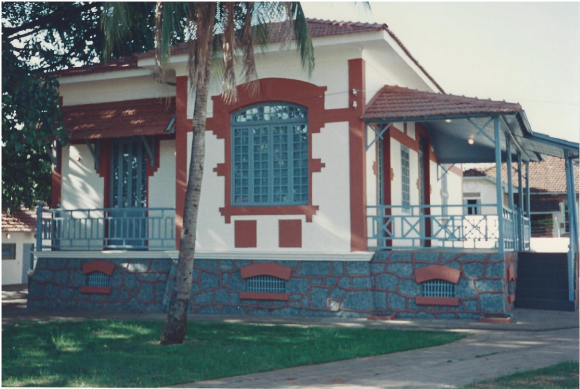
Figura 2 Antiga Casa do Chefe da Estação (Araçatuba), atual Museu Ferroviário. Fonte: Museu Ferroviário “Moisés Joaquim Rodrigues”
