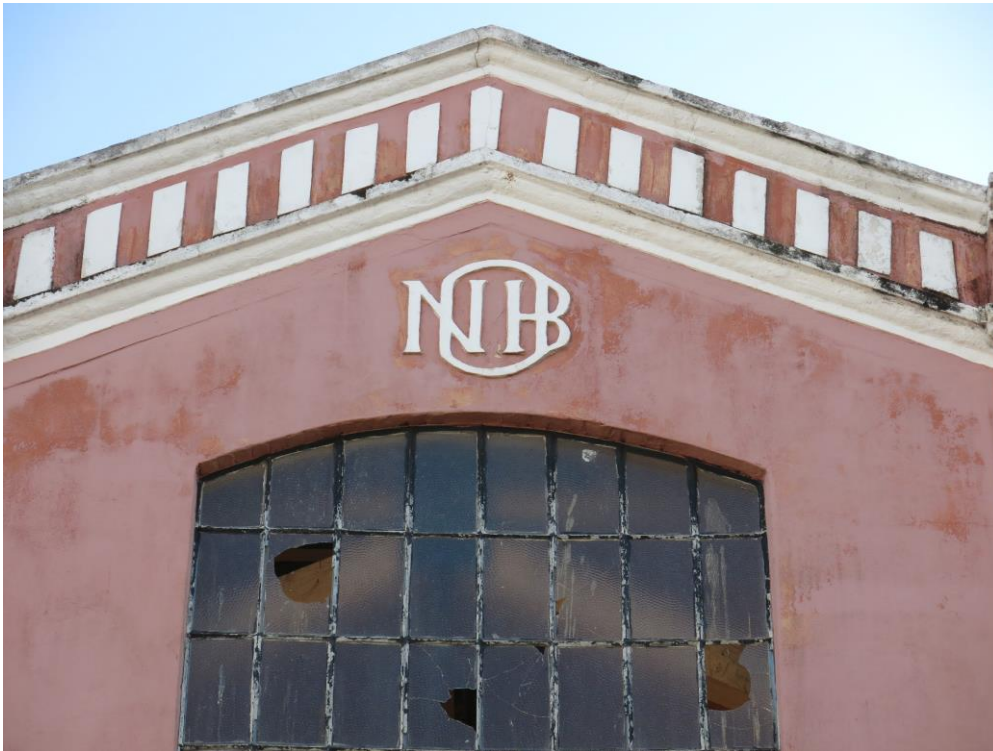
Figura 15 Depósito de Locomotivas de Araçatuba - Logotipo NOB (ala Leste). Fonte: Instituto Pedra
