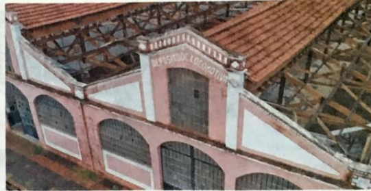
ABANDONO Em vista aérea, situação do Centro Cultural é de abandono e deterioração, pois está interdito desde 2009
