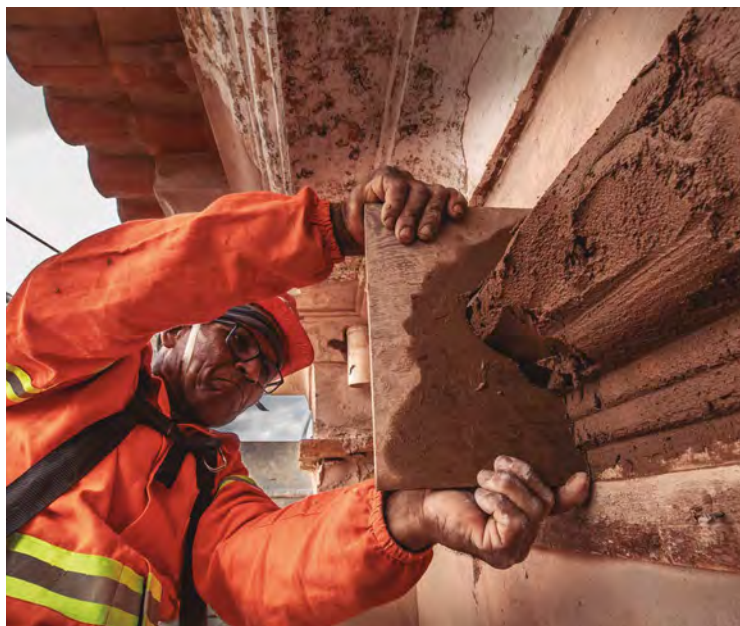
À ESQUERDA Restauração das cimalthas com moldes criados a partir de sua ornamentação original
