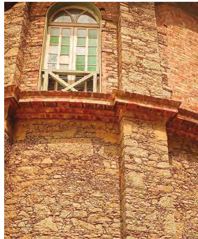
ACIMA Interior do templo À ESQUERDA Detalhe construtivo das paredes externas FOTOS Rafael Adorján/Acervo Instituto Pedra
