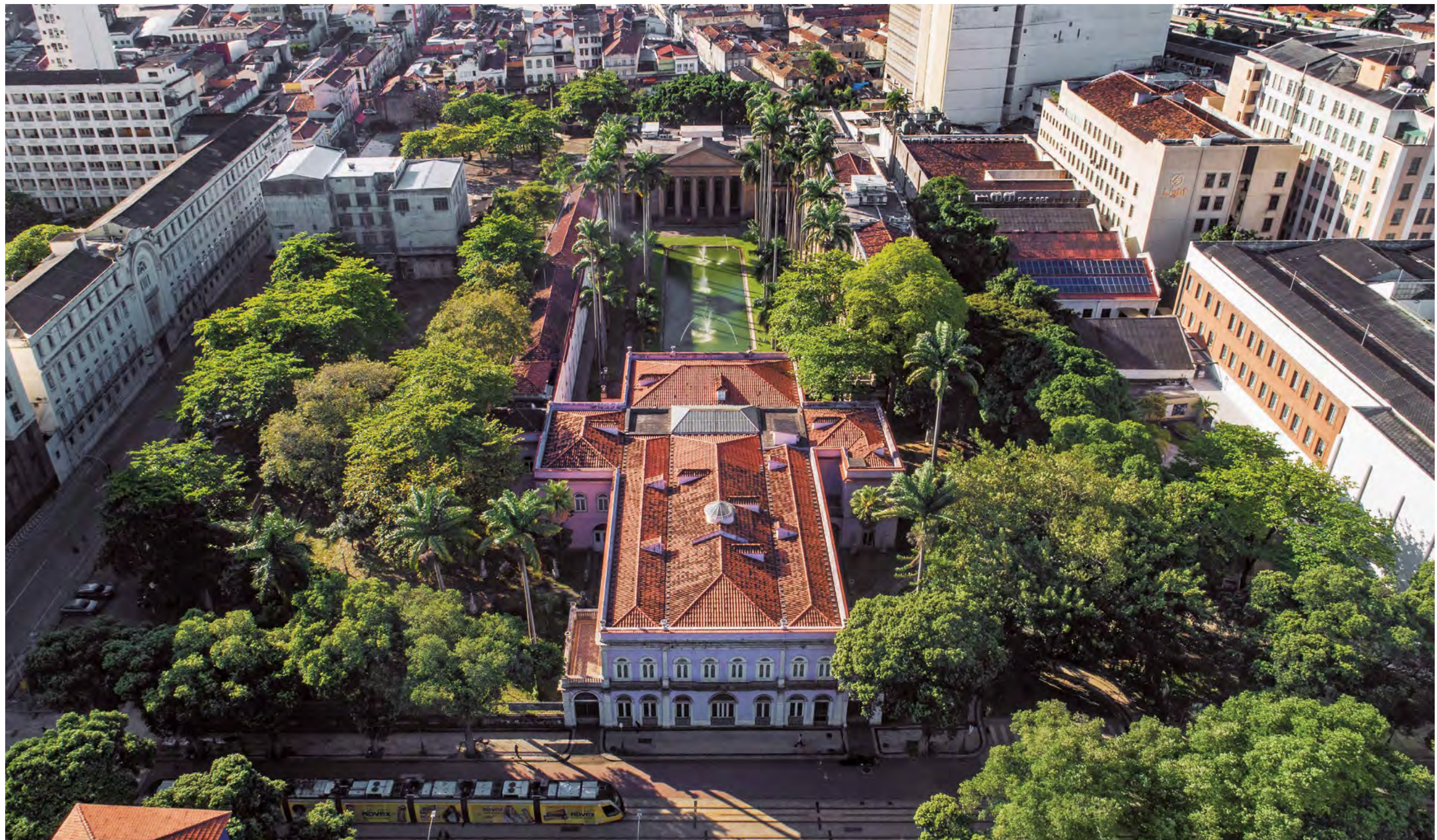
Imagem aérea do complexo FOTOS Nelson Kon/Acervo Instituto Pedra
