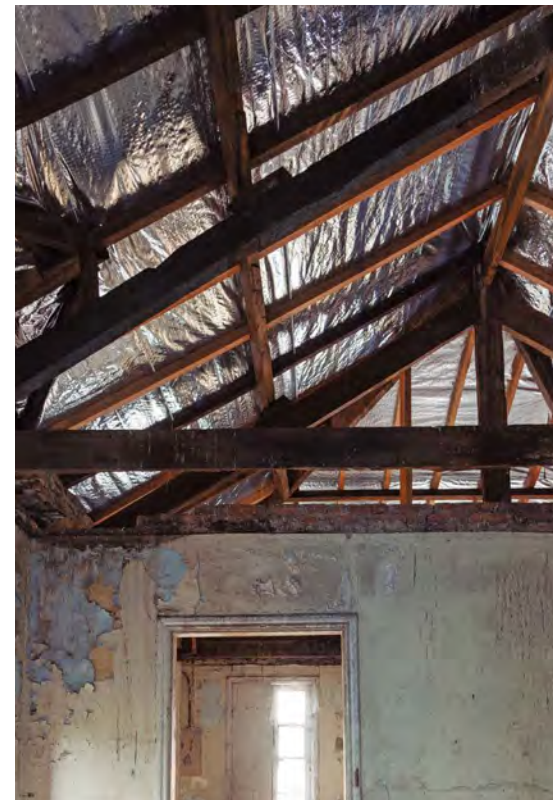
NO TOPO DA PÁGINA Laje da casa nº 8 À ESQUERDA Restauração da cobertura da casa nº 8 FOTOS Mayra Azzi/Acervo Instituto Pedra
