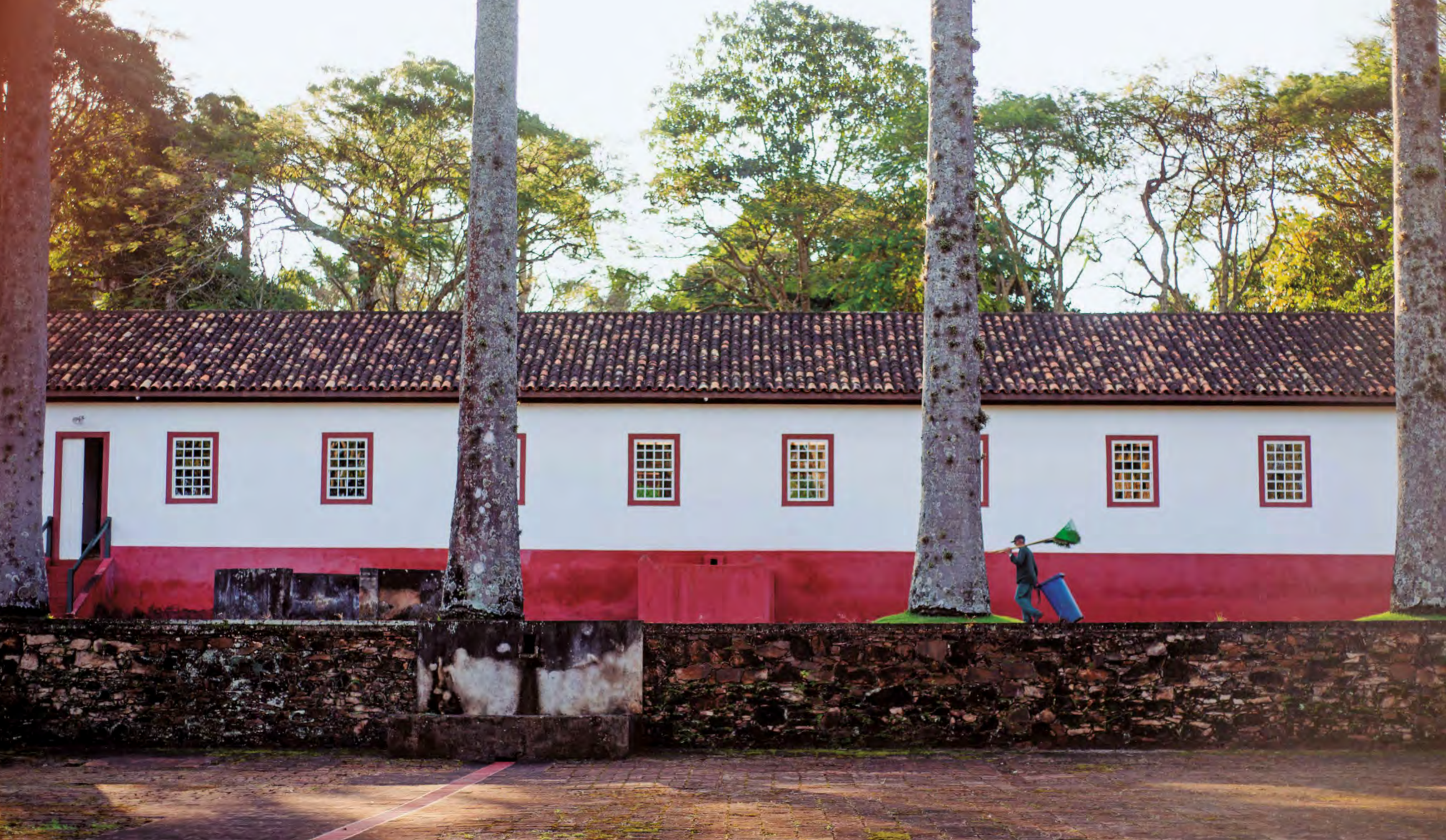
Fachada do prédio da antiga senzala Foto Oscar Neto/Acervo Instituto Pedra
