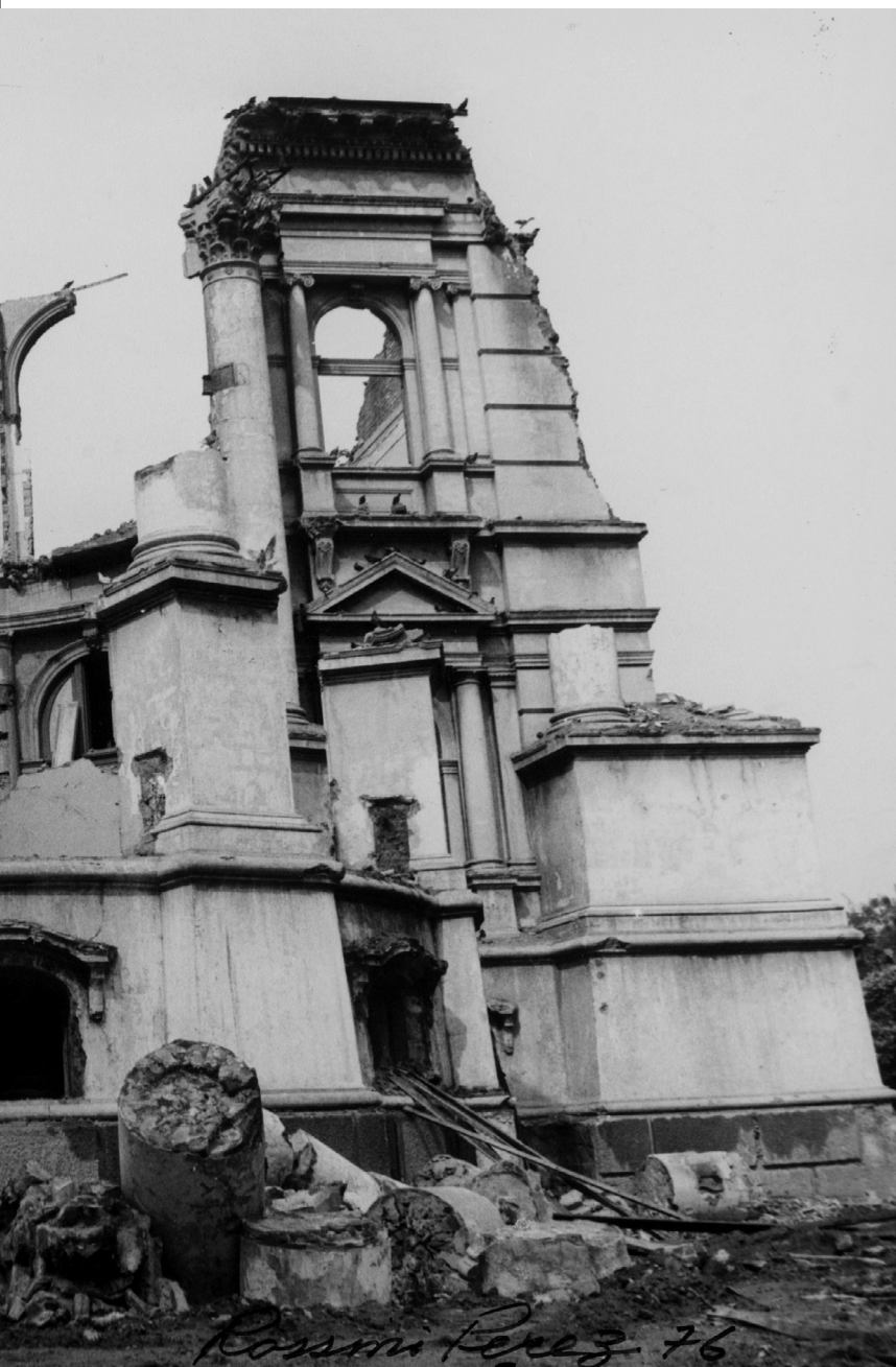
Demolição do Palácio Monroe | Rio de Janeiro (RJ) [1976] Fotografia Rossini Perez | Fundação Biblioteca Nacional
