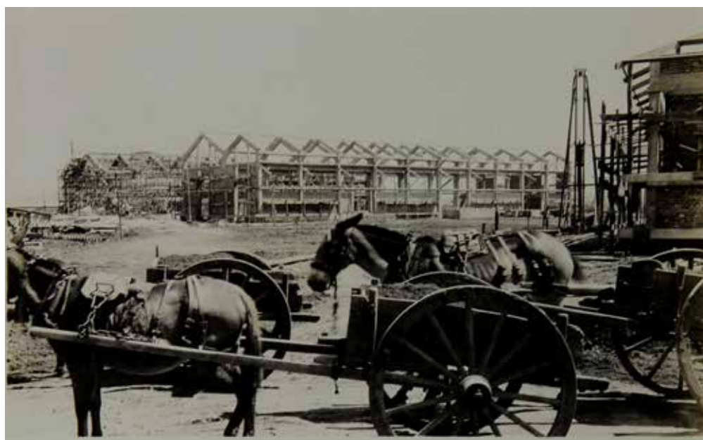
Nesta página e na seguinte, imagens das primeiras edificações do campus do IPT, no bairro do Butantã, em São Paulo (SP).
