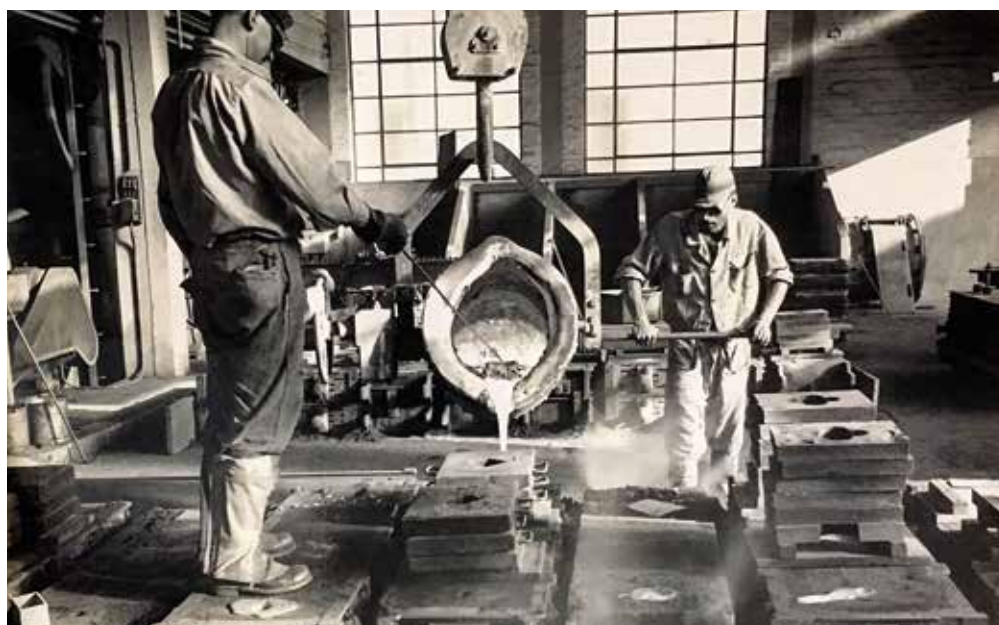
Galpão de Metalurgia do IPT, onde foi produzido o primeiro chumbo refinado do país. O instituto deu suporte tecnológico à implantação da primeira usina siderúrgica no Brasil, em Volta Redonda (RJ), e apoiou o crescimento da indústria automobilística; na imagem ao lado, vazamento de molde com panela de 500 kg.
