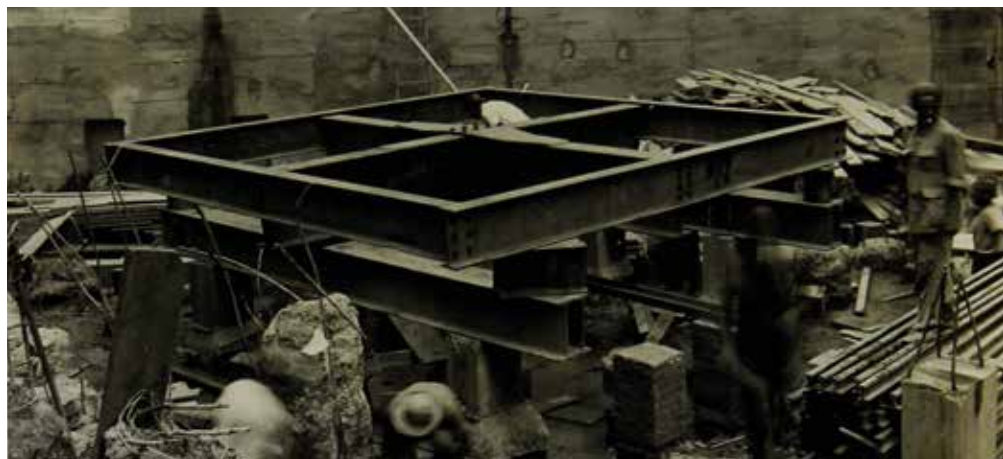
No alto, destroços do edifício do Banco do Brasil, no centro da cidade de São Paulo, após incêndio em 1947. A Seção de Aglomerantes e Concretos do IPT realizou estudos do que restou da estrutura do prédio. Ao lado e abaixo, imagens de prova de carga com estacas Franklin nas fundações do Edifício Altino Arantes, (antigo Banespa, atualmente Farol Santander).
