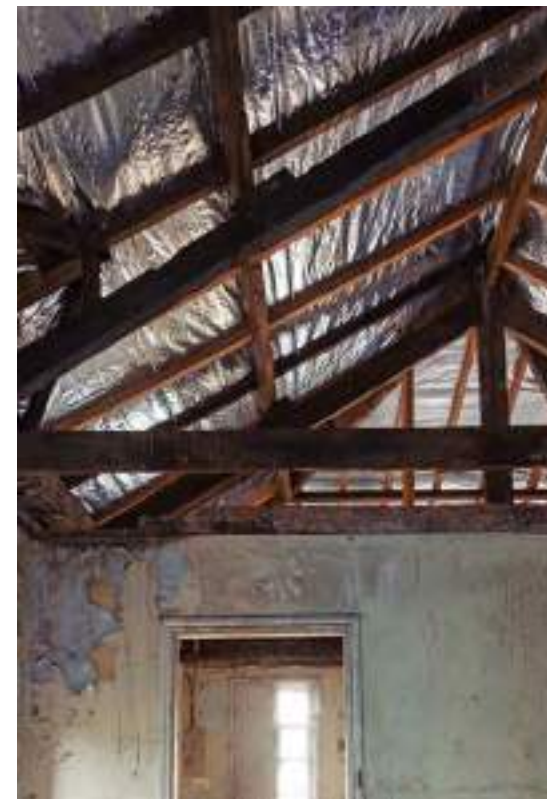
NO TOPO DA PÁGINA Laje da casa nº 8 À ESQUERDA Restauração da cobertura da casa nº 8 FOTOS Mayra Azzi/Acervo Instituto Pedra
