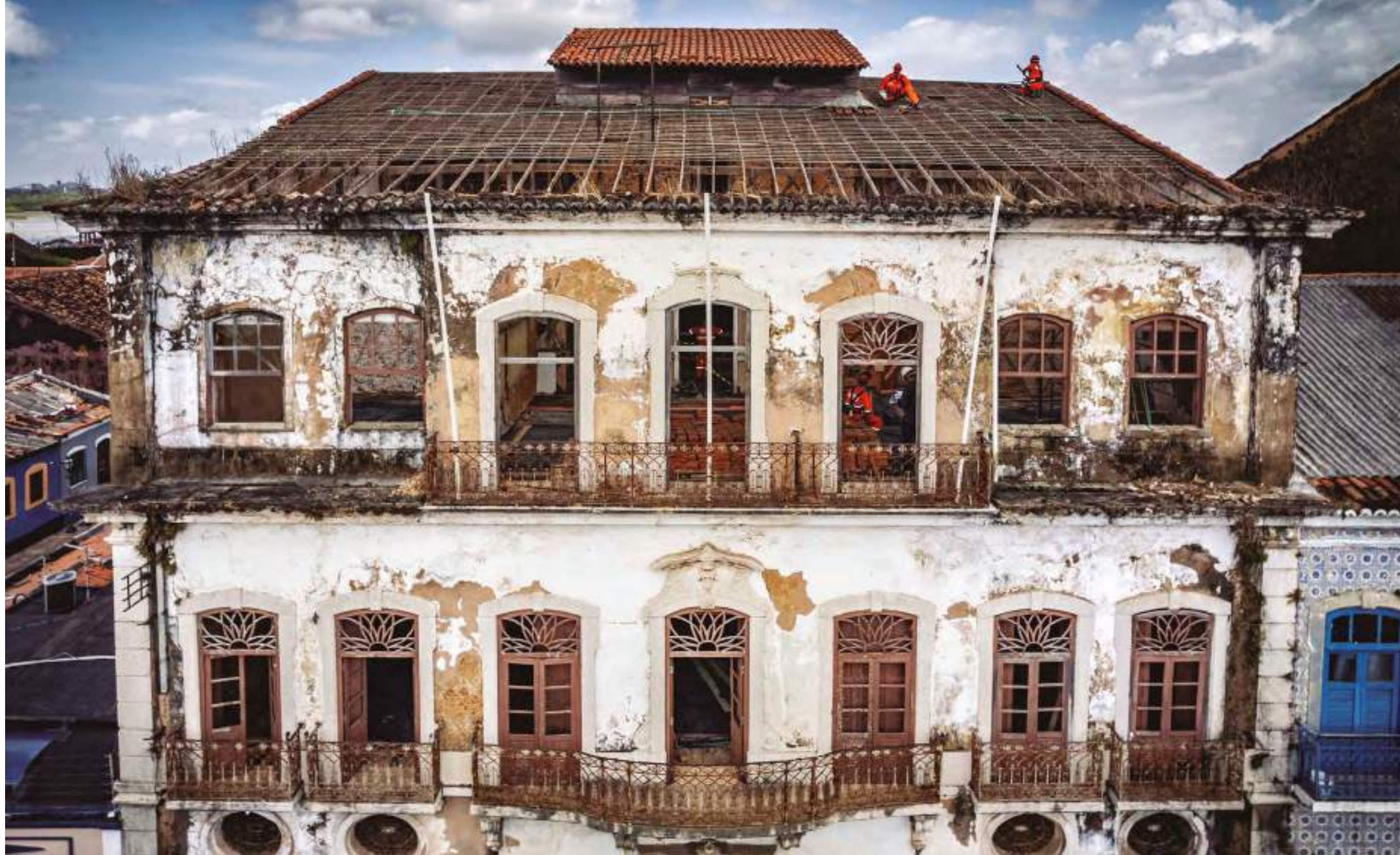
Imagem externa da fachada do Palacete da Rua Formosa antes das obras de restauro Foto Albani Ramos/Acervo Instituto Pedra
