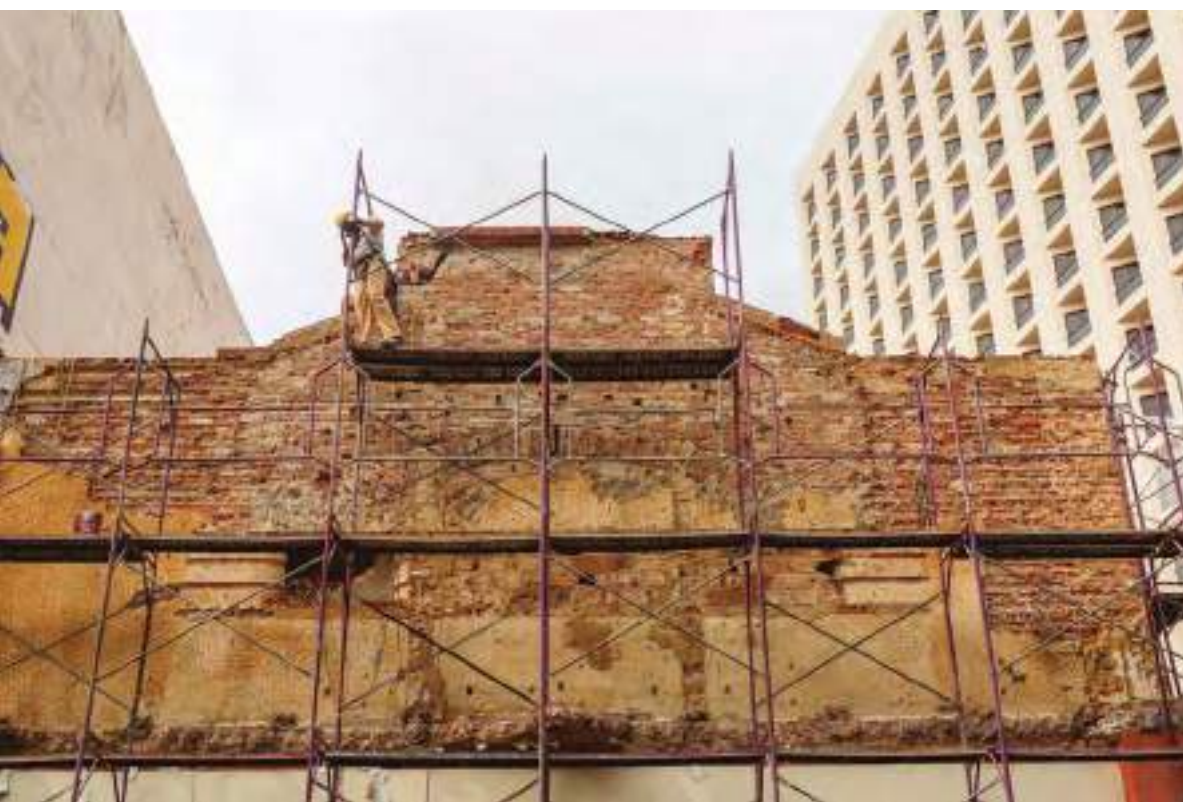
À DIREITA Requalificação da cobertura ABAIXO Prospecções revelaram platibanda e arcos originais na fachada FOTOS Oswaldo Forte/Acervo Instituto Pedra
