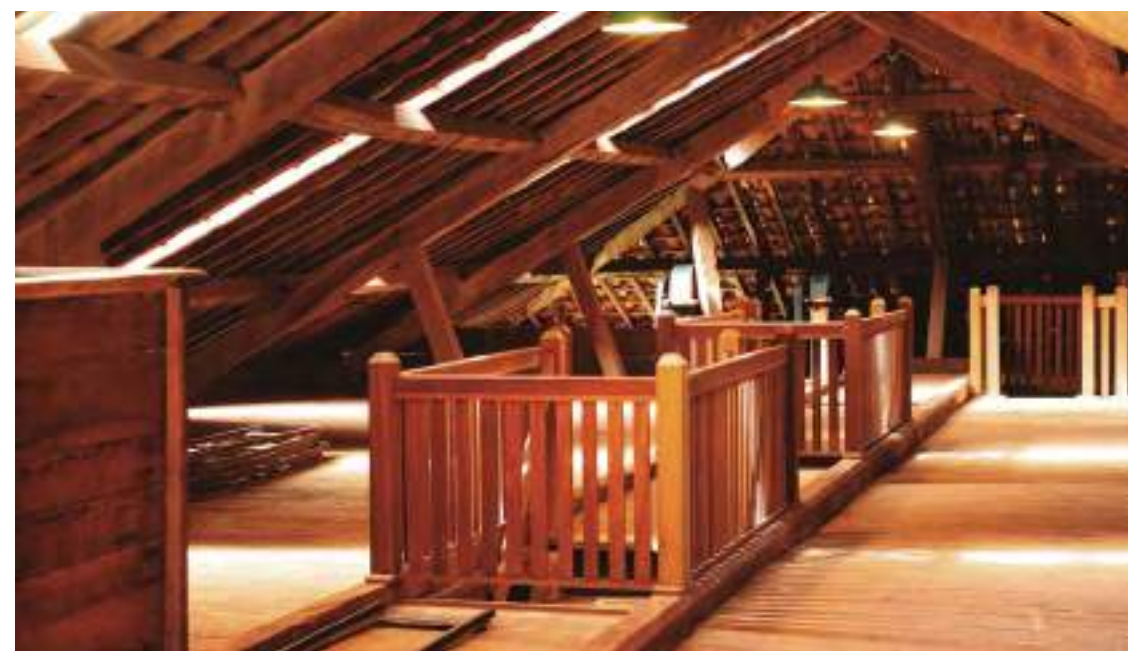
Vista externa e interna da tulha, antigo local de armazenamento e processamento dos grãos de café FOTOS Oscar Neto/Acervo Instituto Pedra
