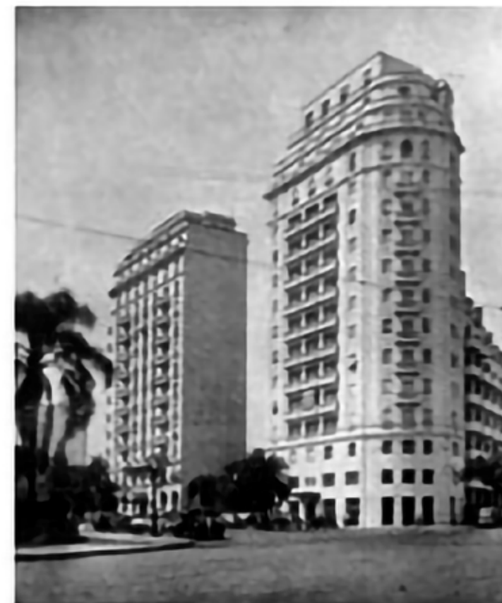
EDIFÍCIOS SÃO LUÍS E SÃO NICOLAU
