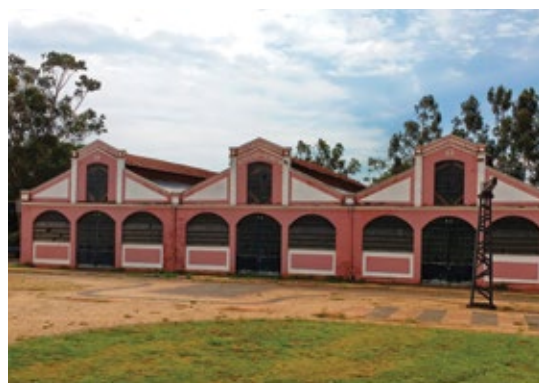
Ferrovárias na Oficina de Locomotivas: destaque para abertura posterior
