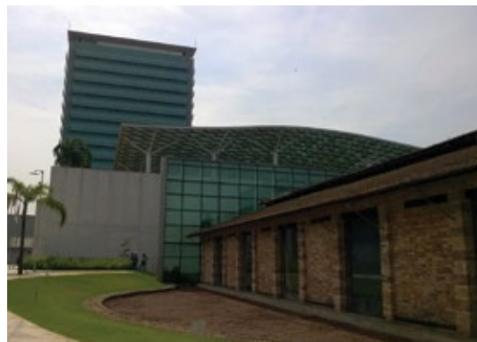
Vista da fachada após a finalização das obras de restauro do armazém e revisão do projeto de paisagismo
