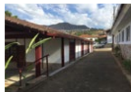
Galpão e edificações durante reforma
