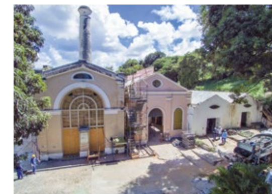
Obras de revitalização do Parque do Queimado
