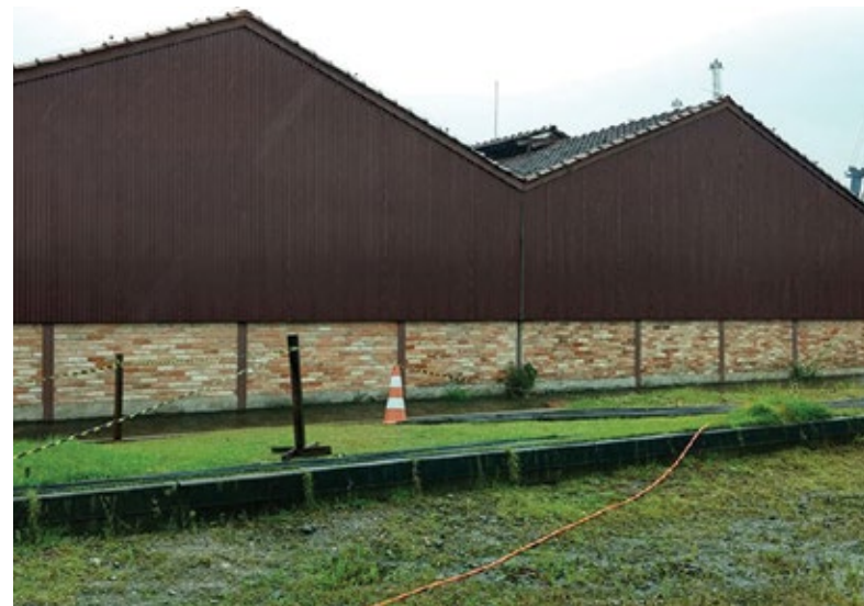
Reintegração de parede de alvenaria de tijolos durante processo de restauro
