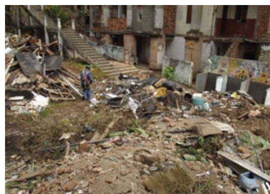
Remoção de entulho antes do início das obras, em dezembro de 2014
