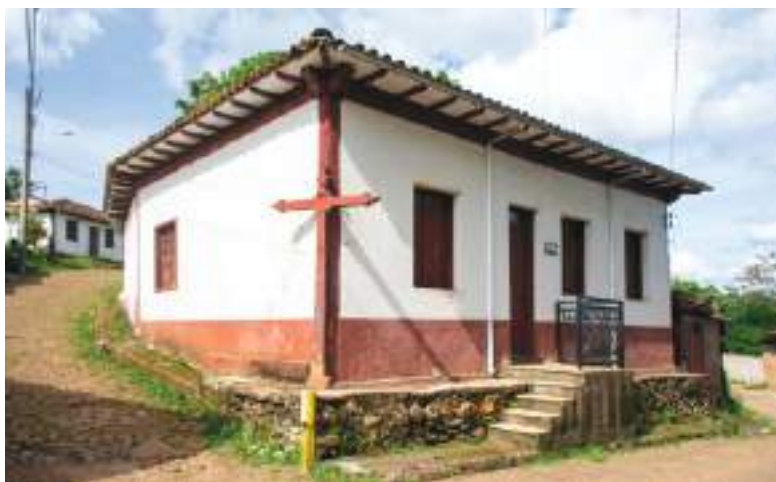
FIG. 12 Casa térrea e cruzeiro situados à Rua da Glória, Bandeirantes. Foto dos autores, 2022.
