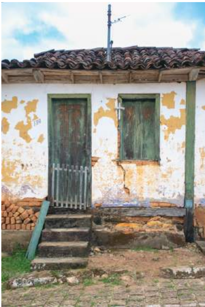
FIG. 104 Exemplo de edificação civil com estrutura autônoma de madeira e vedação em tijolos cerâmicos maciços, Cláudio Manoel. Foto dos autores, 2022.
