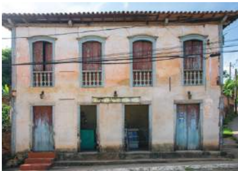
FIG. 40 Sobrado situado à Rua Vicente Veríssimo, Padre Viegas. Foto dos autores, 2022.
