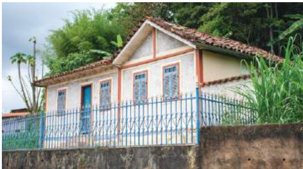
FIG. 17 Casa térrea situada à rodovia MG 326, Cláudio Manoel. Foto dos autores, 2022.
