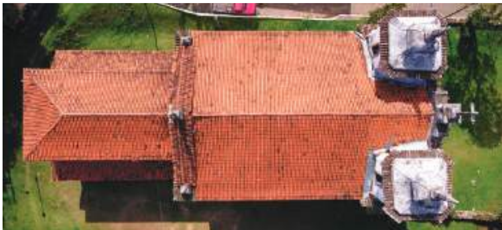
FIG. 134 Diversidade de soluções de cobertura em edificação religiosa de Mariana - MG. Foto dos autores, 2022.
