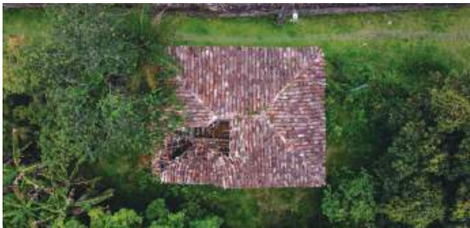
FIG. 133 Telhado em quatro águas em edificação civil de Mariana - MG. Foto dos autores, 2022.
