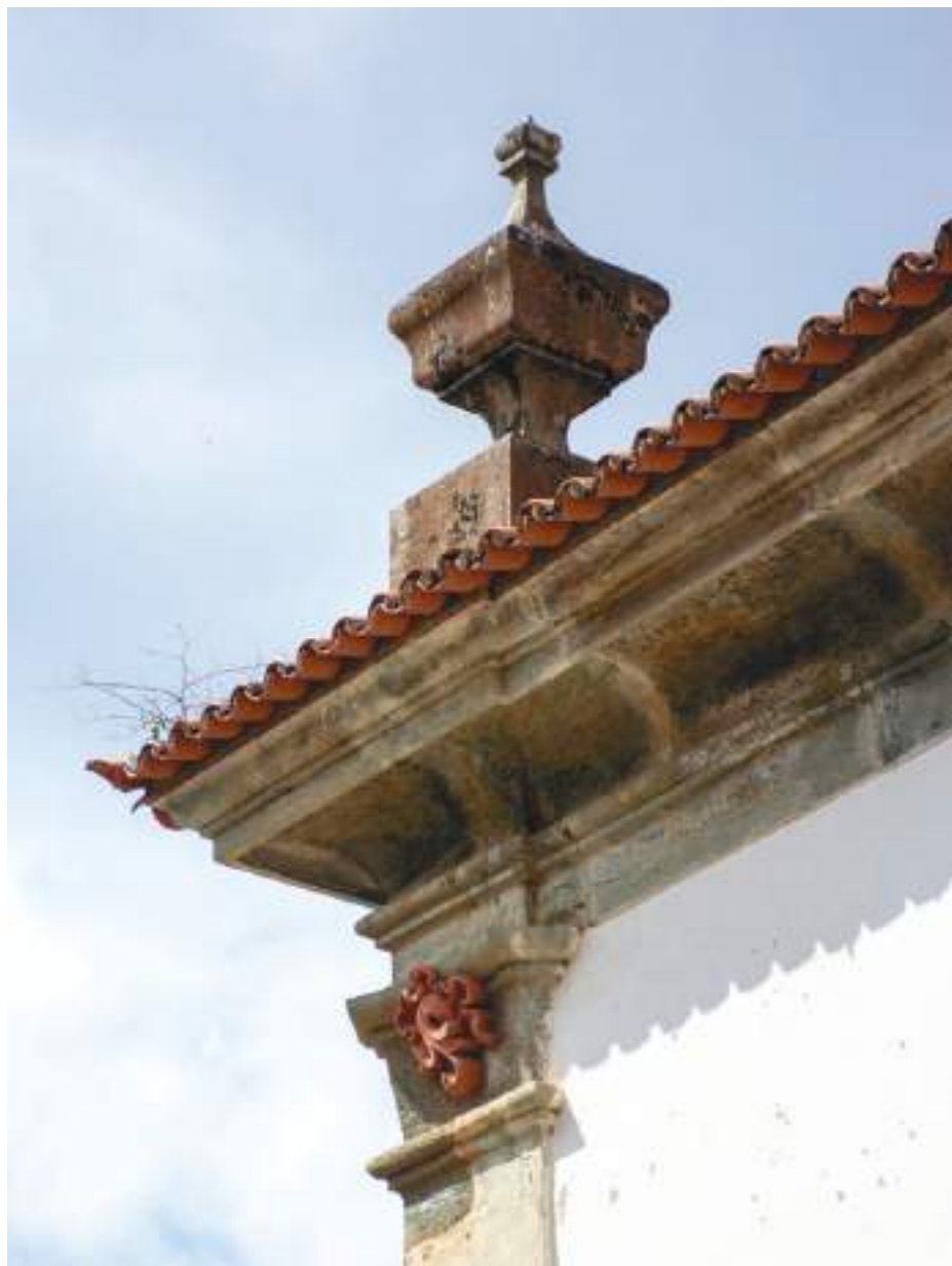
FIG. 150 Cimalha de cantaria da Igreja Matriz de Bom Jesus do Monte, Furquim. Foto dos autores, 2022.
