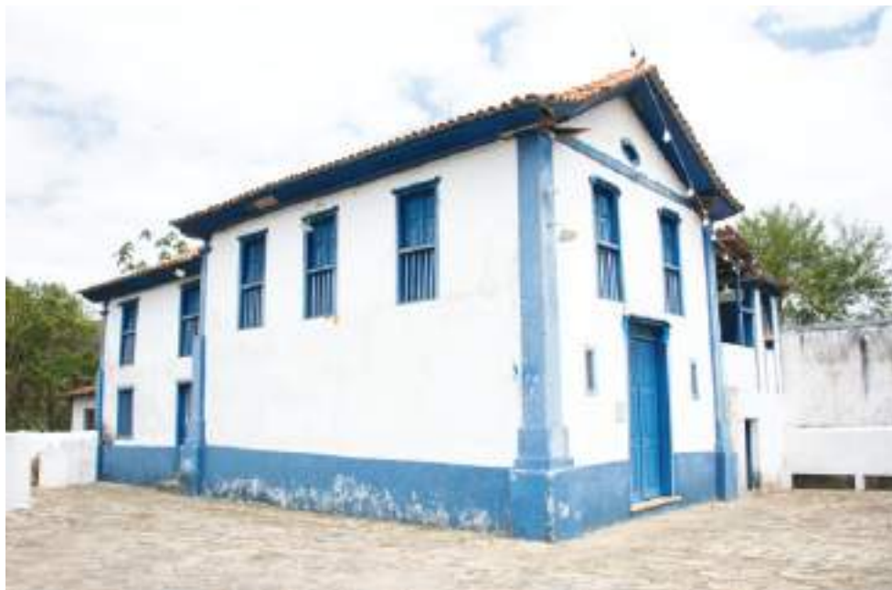
FIG. 20 Capela de Nossa Senhora do Carmo, Furquim. Foto dos autores, 2022.
