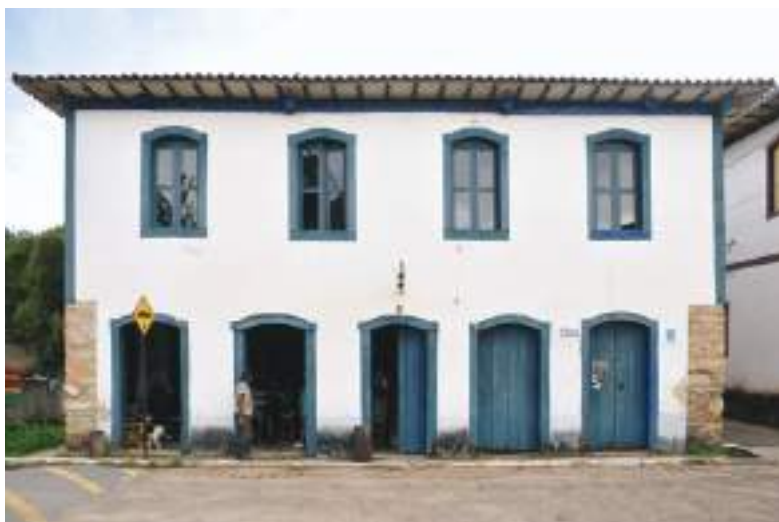
FIG. 91 Abaixo, sobrado em estrutura mista de alvenaria autoportante de pedra e estrutura autônoma de madeira, Monsenhor Horta. Foto dos autores, 2022.
