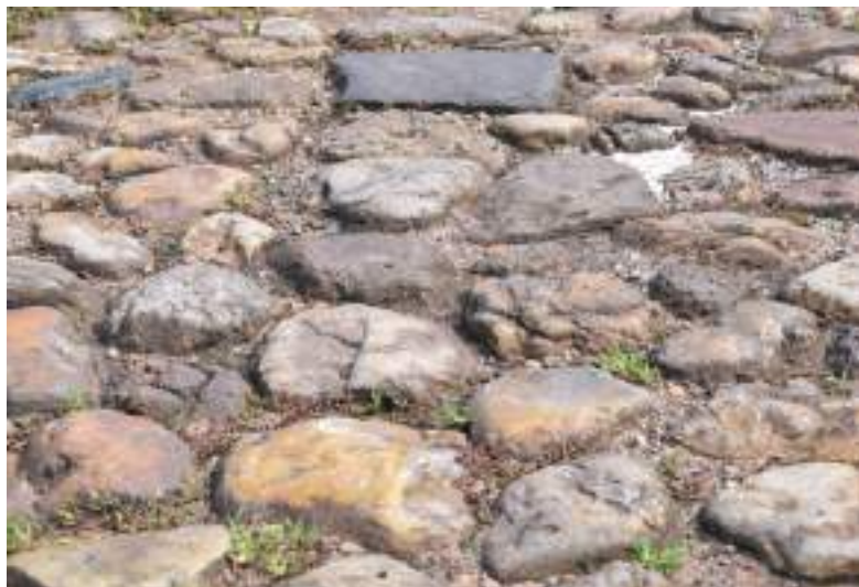
FIG. 182 Detalhe de pavimentação de rua em Mariana, Sede. Foto dos autores, 2022.
