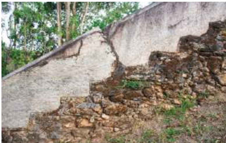
FIG. 171 Guarda-corpo de cantaria da escadaria da Igreja de Nossa Senhora da Conceição, Camargos. Foto dos autores, 2022
