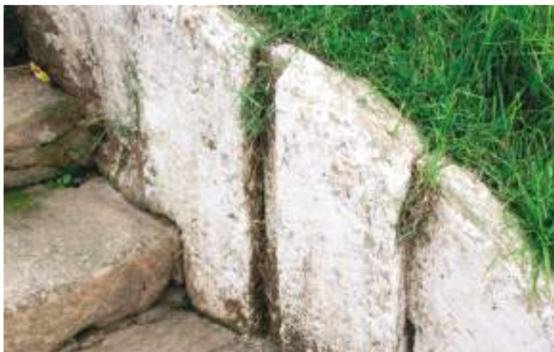
FIG. 170 Detalhe dos encaixes do guarda-corpo de cantaria da escadaria lateral da Igreja Matriz de Nossa Senhora da Conceição, Cachoeira do Brumado. Foto dos autores, 2022.
