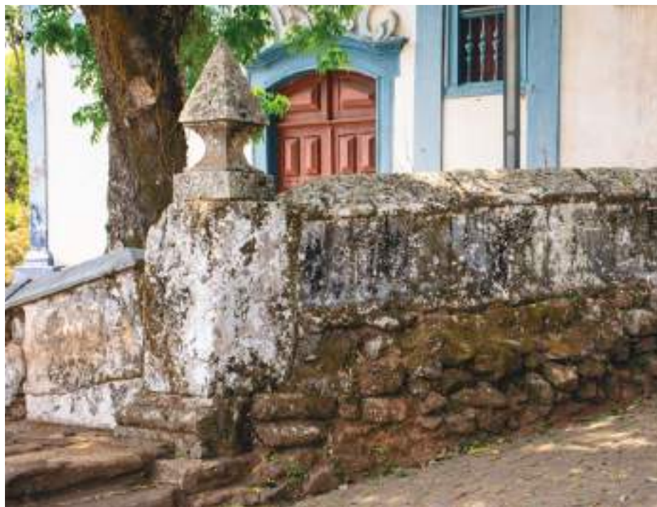
FIG. 107 Muro de divisa do cemitério da Igreja de Nossa Senhora do Rosário dos Homens Pretos, Santa Rita Durão. Foto dos autores, 2022.
