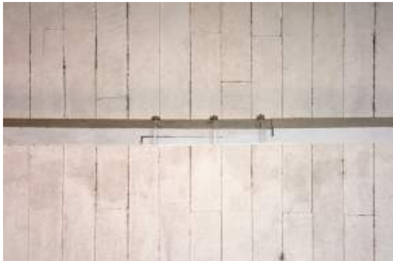
FIG. 141 Detalhe de reforço metálico em tirante da estrutura da cobertura da Igreja de Nossa Senhora Rainha dos Anjos, Mariana - Sede. Foto dos autores, 2022.
