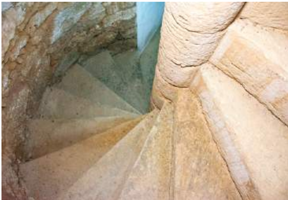
FIG. 166 Escada helicoidal de pedra. Igreja Matriz Nossa Senhora do Rosário, Padre Viegas. Foto dos autores, 2022.
