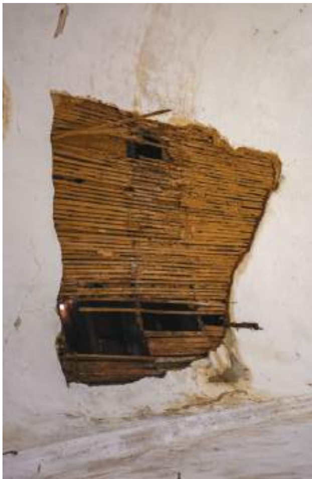
FIG. 163 Forro de estuque da Casa do Conde de Assumar, Mariana - Sede. Foto dos autores, 2022.
