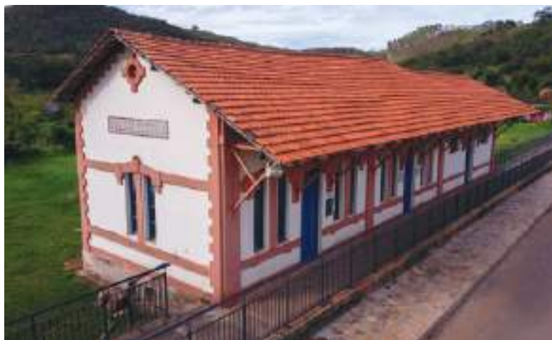
FIG. 10 Antiga estação ferroviária Ribeirão do Carmo, Bandeirantes. Foto dos autores, 2022.
