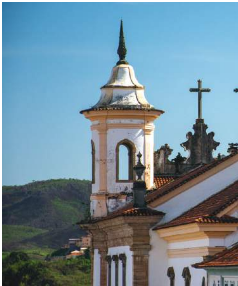
FIG. 157 Cúpulas de alvenaria das torres da Igreja de Nossa Senhora do Carmo em primeiro plano, e da Igreja de São Francisco de Assis em segundo plano. Mariana - Sede. Foto dos autores, 2022.
