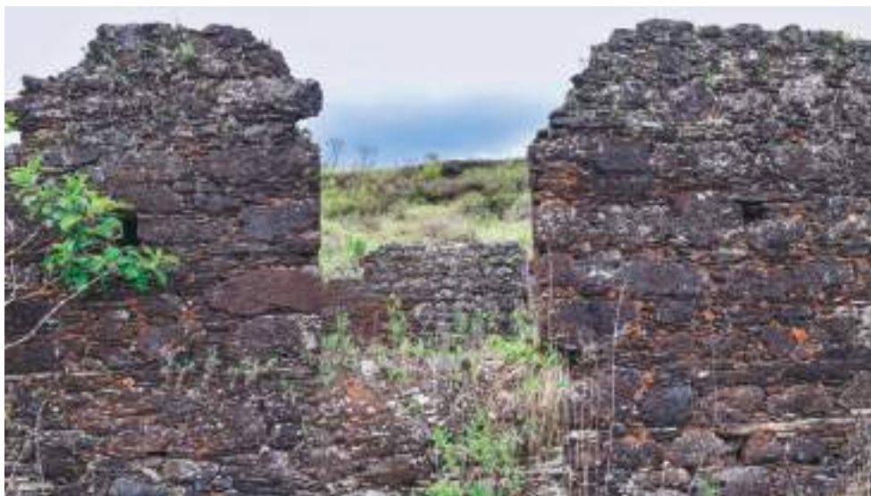
FIG. 69 Acima, alvenaria de pedra seca de muro de divisa, Santa Rita Durão. Foto dos autores, 2022.
