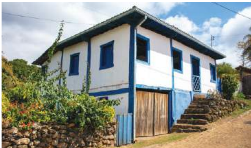
FIG. 84 Sobrado em estrutura autônoma de madeira, Santa Rita Durão. Foto dos autores, 2022.
