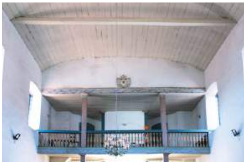
FIG. 140 Tirante da estrutura da cobertura da Igreja de Nossa Senhora Rainha dos Anjos, Mariana - Sede. Foto dos autores, 2022.
