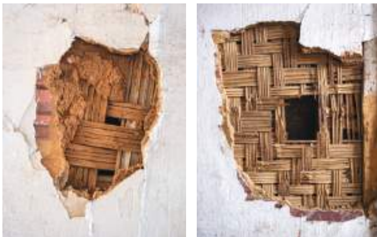
FIG. 96 E FIG. 97 Paredes de estuque na Casa do Conde de Assumar, Mariana - Sede. Foto dos autores, 2022.
