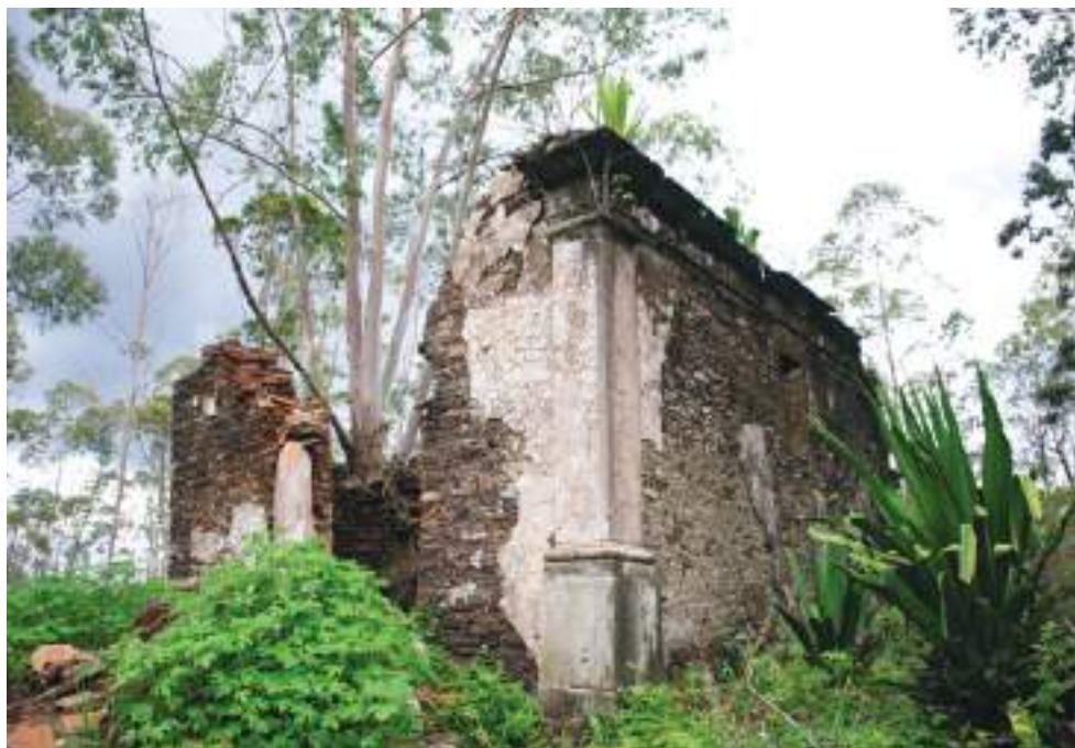
FIG. 48 Ruínas da antiga Igreja Anglicana dos Ingleses, Passagem de Mariana. Foto dos autores, 2022.
