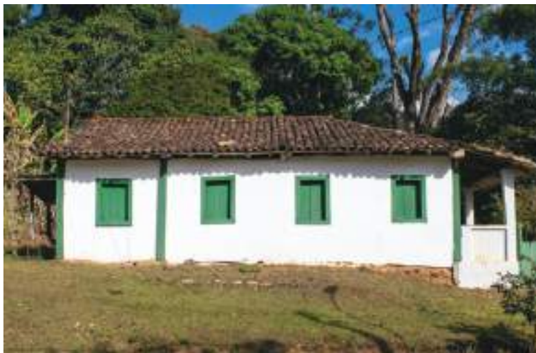
FIG. 52 Casa térrea situada à Rua do Rosário, Santa Rita Durão. Foto dos autores, 2021.
