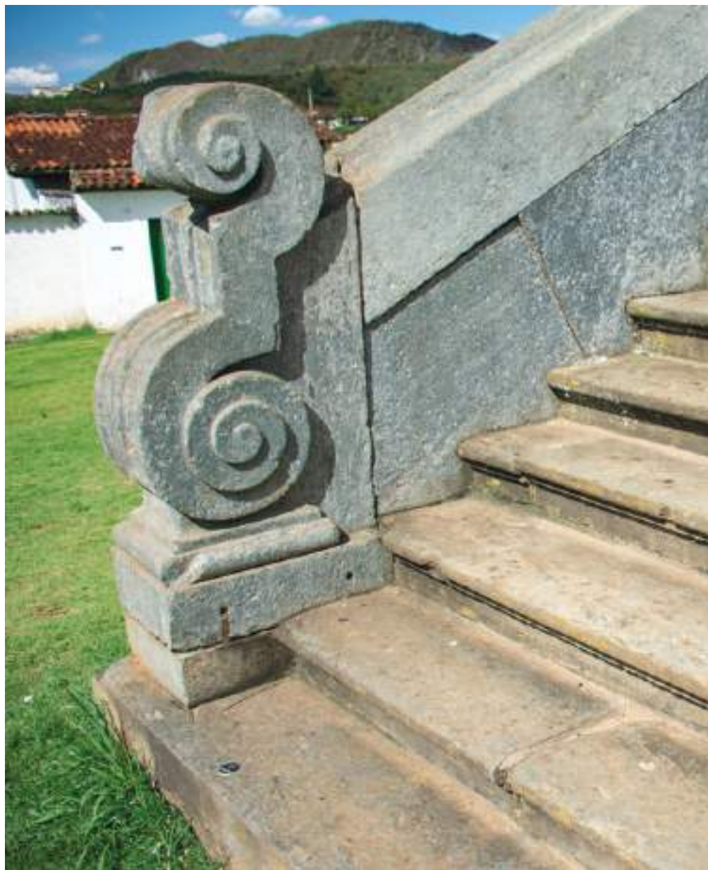
FIG. 168 Guarda-corpo de cantaria da escadaria da Igreja de São Francisco de Assis, Mariana - Sede. Foto dos autores, 2022.
