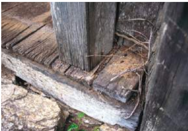
FIG. 117 Acima, vista abaixo do barroteamento que sustenta o piso tabuado de casa térrea elevada do solo, Cláudio Manoel. Foto dos autores, 2022.
