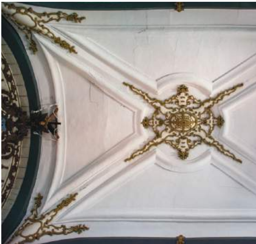
FIG. 162 Forro de estuque da Igreja de Nossa Senhora Rainha dos Anjos, Mariana - Sede. Foto dos autores, 2022.
