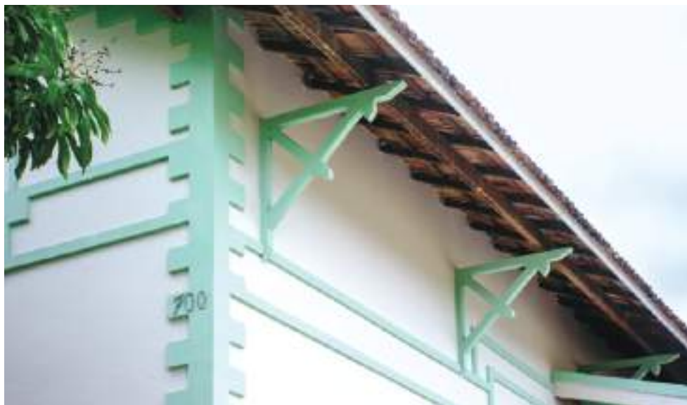
FIG. 152 Mão-francesa do beiral do telhado de edificação civil, Cláudio Manoel. Foto dos autores, 2022.
