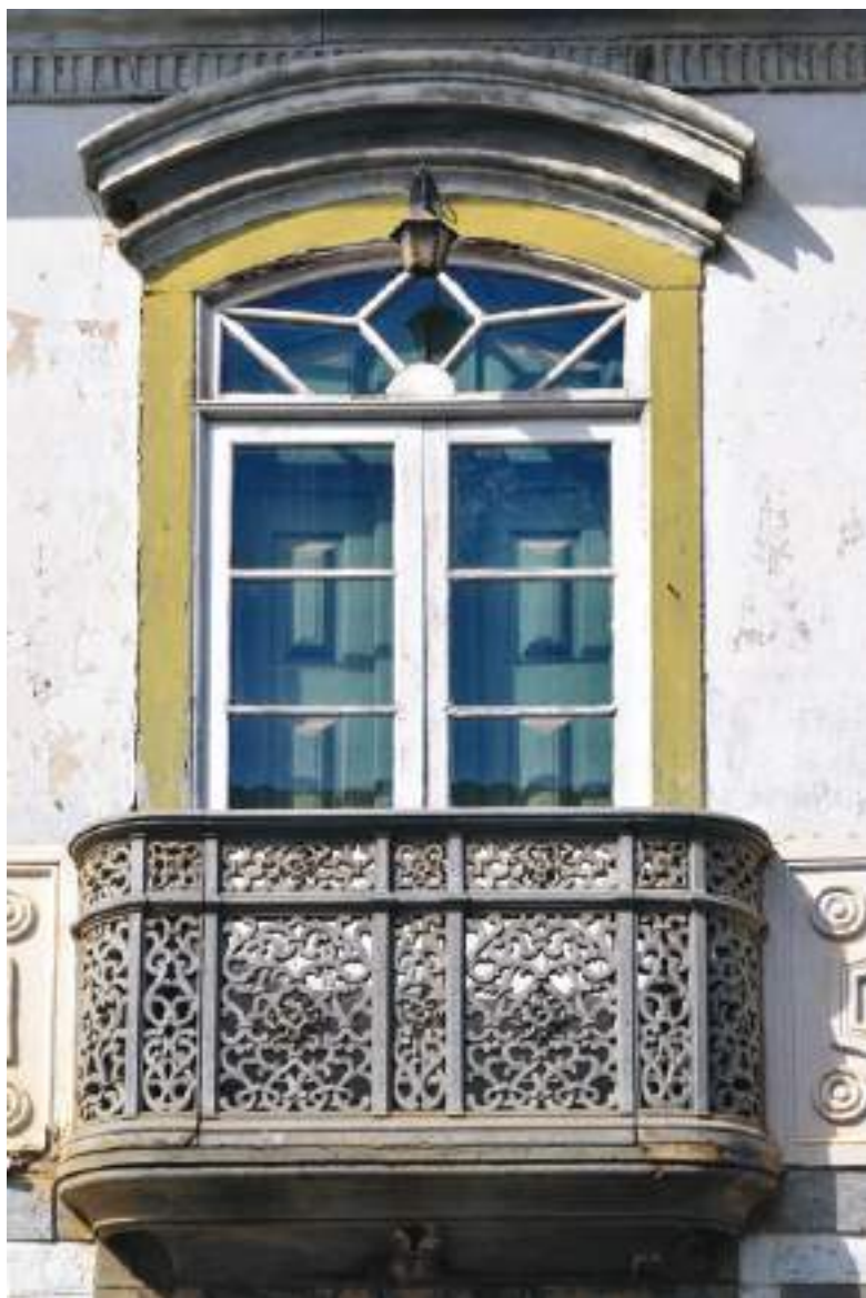
FIG. 127 Janela sacada da casa do Barão de Pontal, Mariana - Sede. Foto dos autores, 2022.
