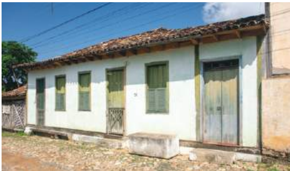
FIG. 34 Casa térrea situada à Rua Fernando Batista Macedo, Monsenhor Horta. Foto dos autores, 2022.
