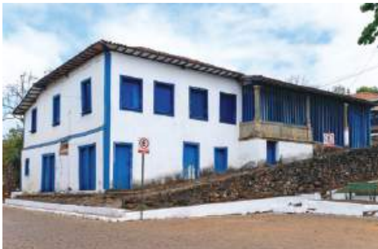
FIG. 53 Sobrado situado à Praça Nossa Senhora de Nazaré, Santa Rita Durão. Foto dos autores, 2021.
