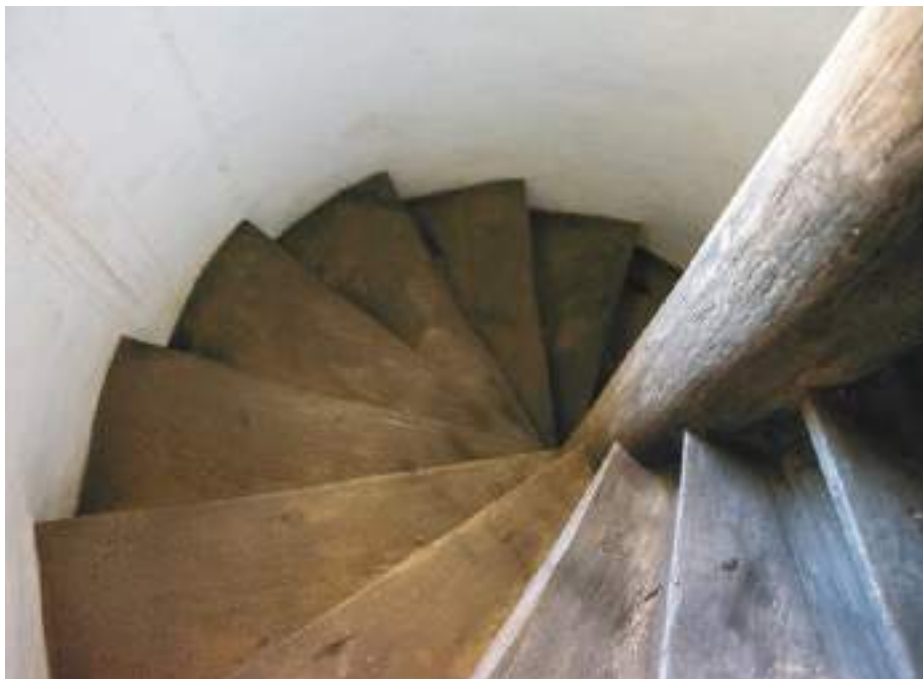
FIG. 165 Escada helicoidal de madeira com esteio de pilão. Igreja de São Francisco de Assis, Mariana - Sede. Foto dos autores, 2022.
