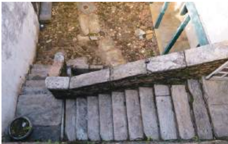
FIG. 169 Guarda-corpo de alvenaria de pedra da escada do pátio da sede do Centro de Apoio ao Turista, Mariana - Sede. Foto dos autores, 2022.
