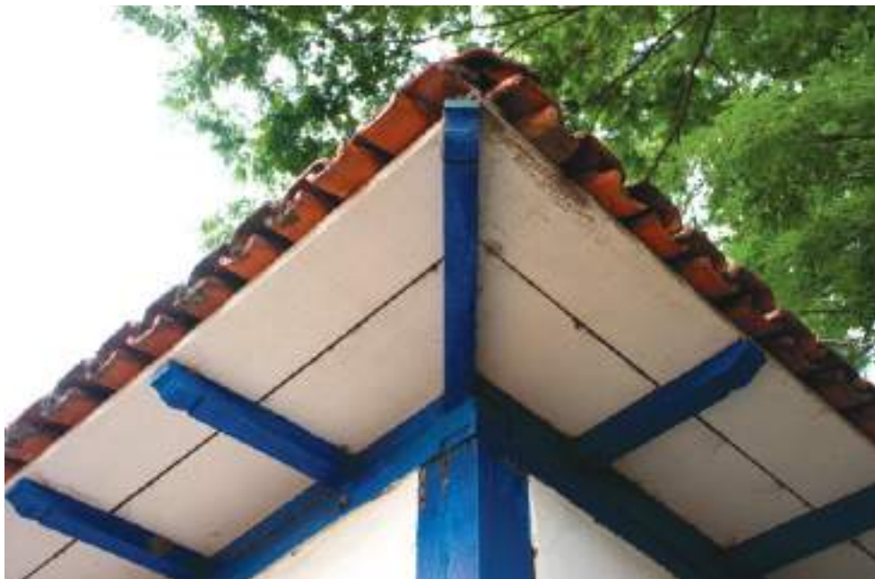
FIG. 148 Beiral encachorrado com guarda-pó em edificação civil, Santa Rita Durão. Foto dos autores, 2022.
