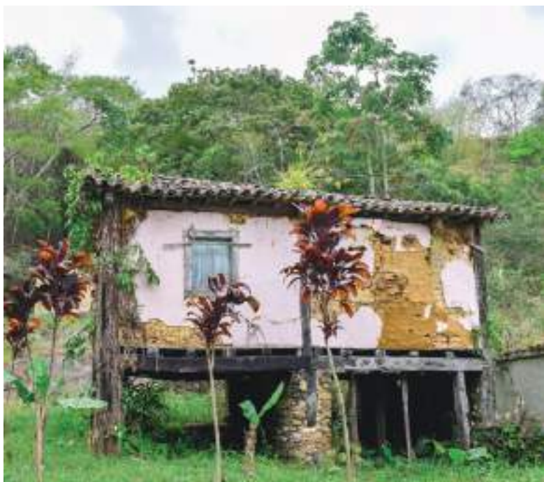
FIG. 194 Moinho hidráulico, último exemplar de uma sequência de moinhos existentes em Furquim. Foto dos autores, 2022.
