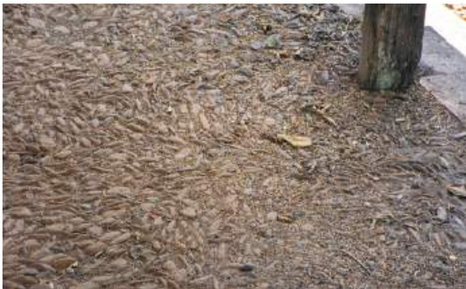
FIG. 113 Acima, seixos rolados em piso de patamar de escada interna, Mariana - Sede. Foto dos autores, 2022.
