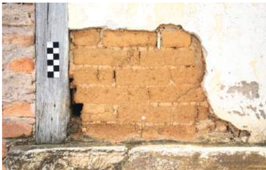
FIG. 101 Acima, parede de adobe da Igreja de Nossa Senhora da Conceição, Camargos. Foto dos autores, 2022.
