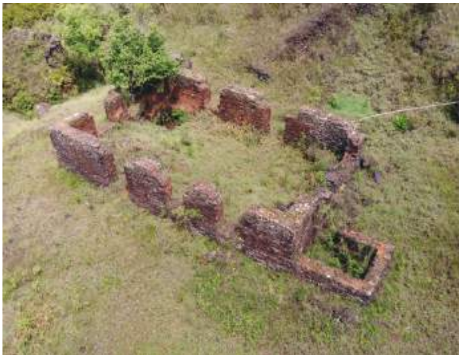
FIG. 45 Ruína situada no Conjunto Paisagístico e Arqueológico do Morro Santo Antônio, Passagem de Mariana. Foto dos autores, 2022.
