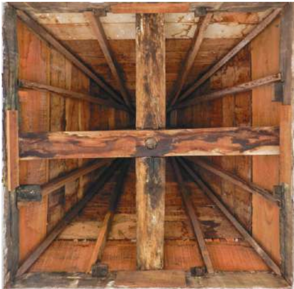
FIG. 137 Madeiramento da cobertura da torre da Igreja Matriz de Nossa Senhora de Nazaré, Santa Rita Durão. Foto dos autores, 2018.
