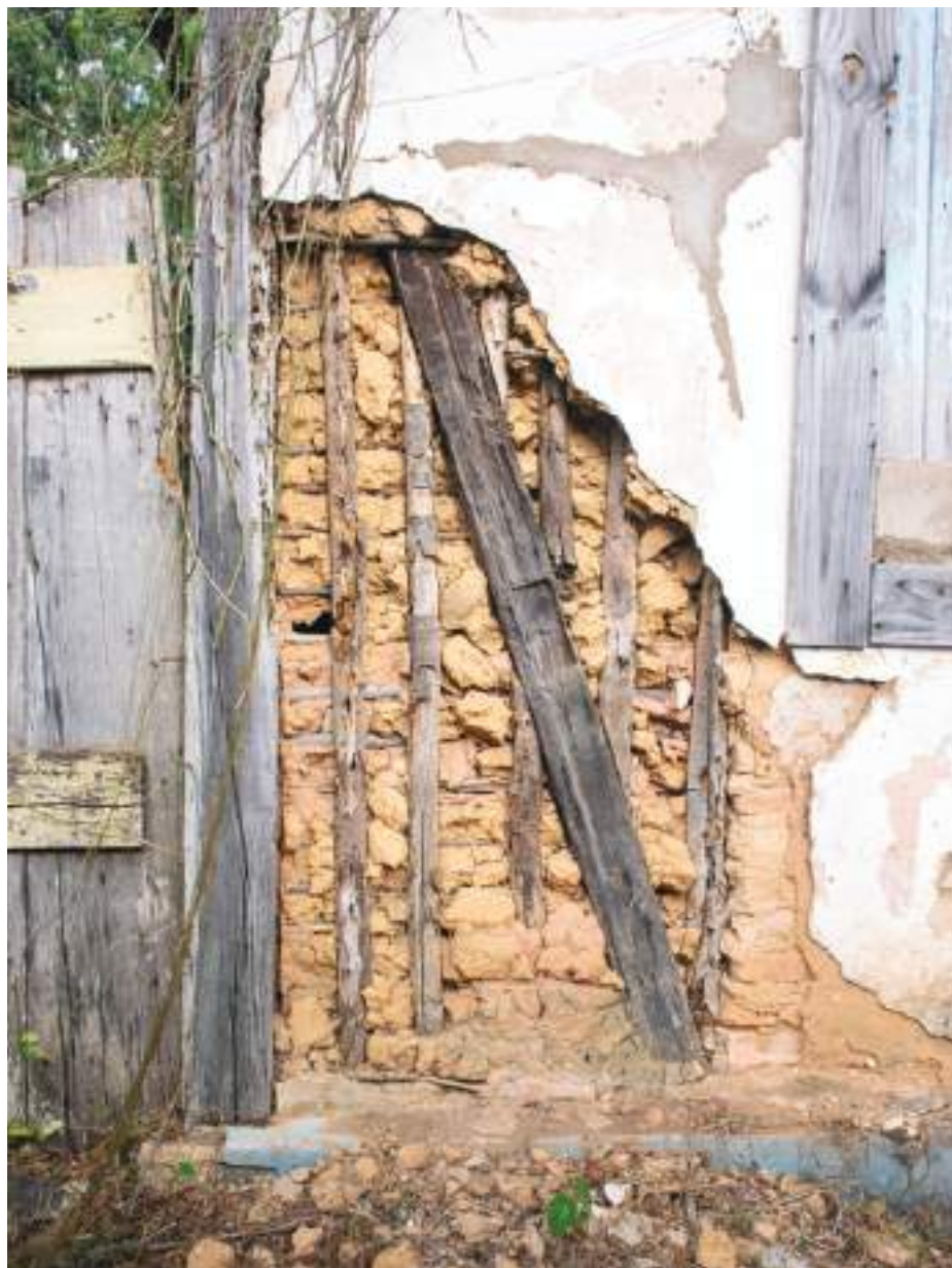
FIG. 92 Exemplo de madeira roliça usada na trama das vedações de pau a pique com a manutenção da casca, Monsenhor Horta. Foto dos autores, 2022.
