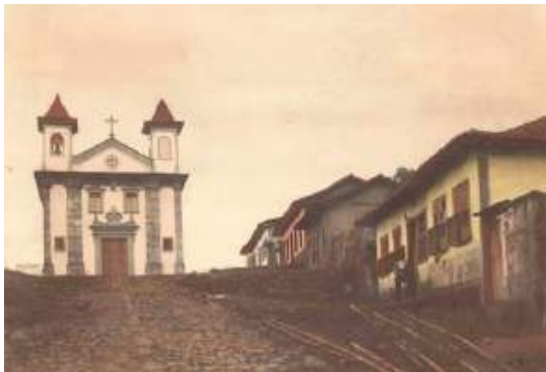
FIG. 181 Via de acesso à Igreja de Nossa Senhora do Rosário dos Homens Pretos. FERBER, sem data. Portal do Arquivo Público Mineiro.
