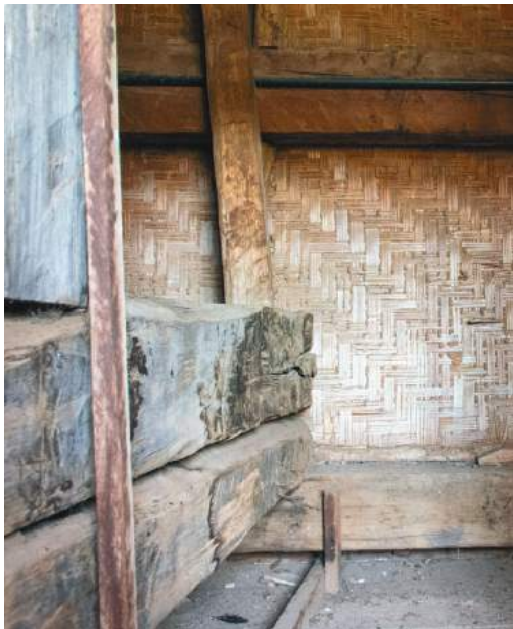
FIG. 98 Parede de estuque na Igreja de Nossa Senhora Rainha dos Anjos, Mariana - Sede. Foto dos autores, 2022.
