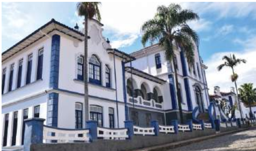
FIG. 80 Colégio Providência fundado em 1850, Mariana - Sede. Foto dos autores, 2022.
