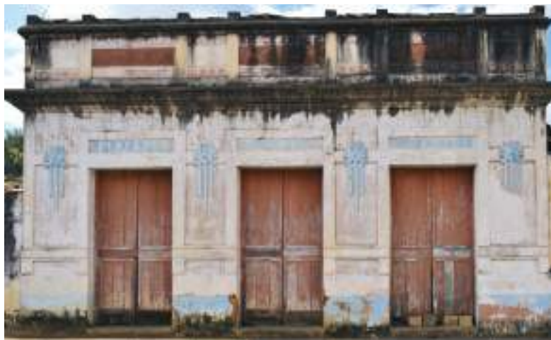
FIG. 4 Rua das Goiabeiras, Furquim. Foto dos autores, 2022.
