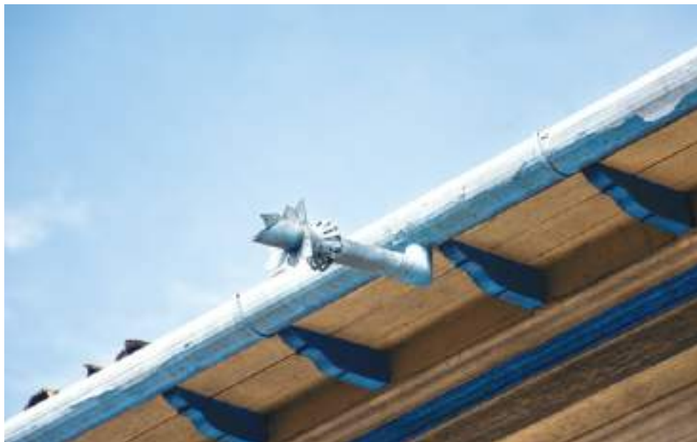
FIG. 151 Cimalha de madeira com cachorro aferente em edificação civil, Mariana - Sede. Foto dos autores, 2022.
