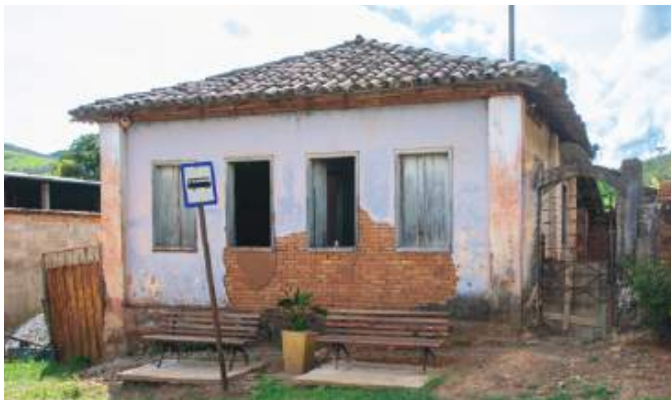
FIG. 81 Casa térrea, Bandeirantes. Foto dos autores, 2022.
