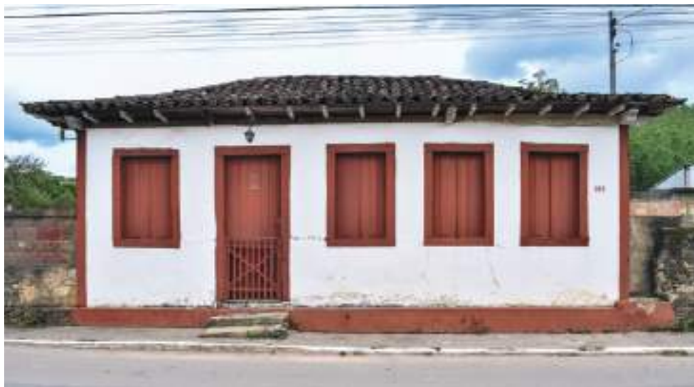
FIG. 35 Casa térrea situada à Rua Santo Antônio, Monsenhor Horta. Foto dos autores, 2022.
