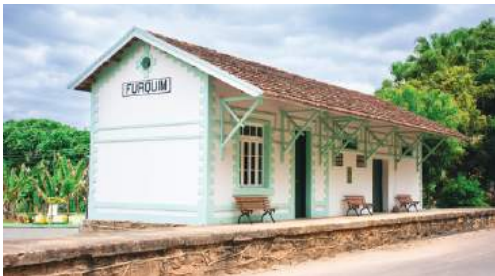
FIG. 21 Antiga estação ferroviária, Furquim. Foto dos autores, 2022.
