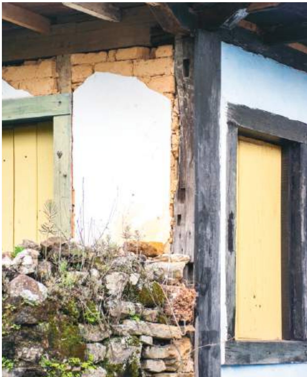
FIG. 103 Sobrado com estrutura autônoma de madeira e vedação em adobes, Monsenhor Horta. Foto dos autores, 2022.
