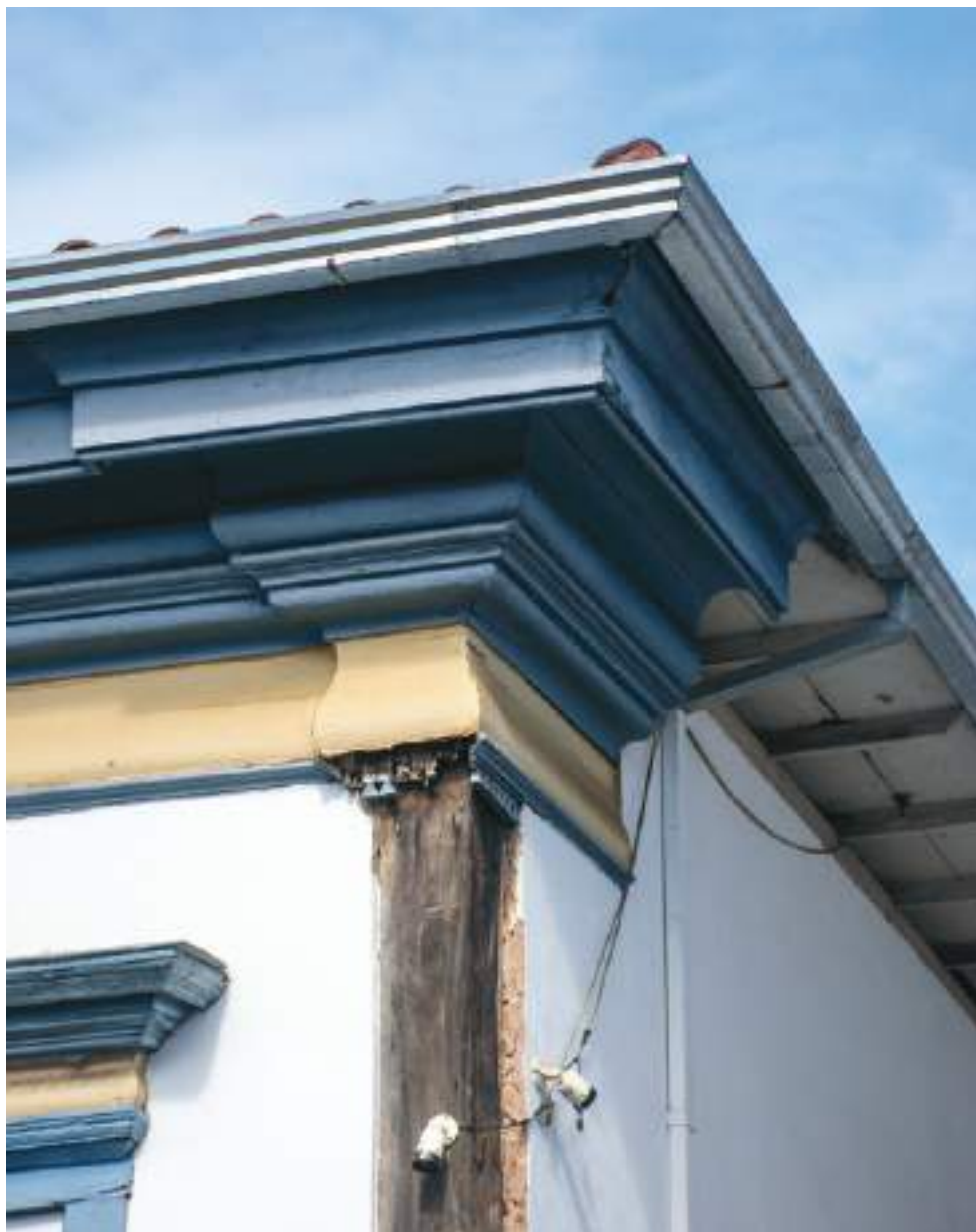
FIG. 149 Cimalha de madeira de casa assobradada, Mariana - Sede. Foto dos autores, 2022.
