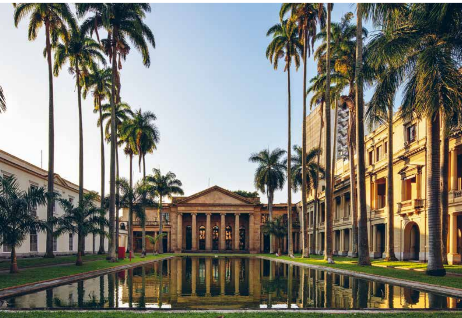
Conjunto do Itamaraty, jardim interno posterior às reformas do período Mangabeira (1928-1930) e nova biblioteca ao fundo, foto atual
