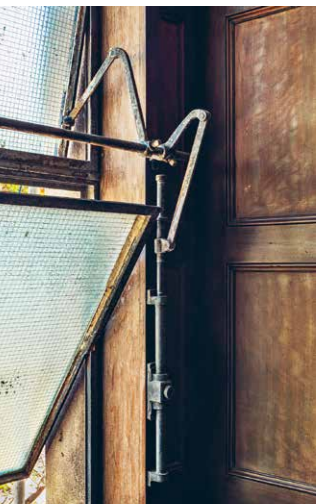
Biblioteca do Itamaraty, mecanismo de acionamento das janelas
