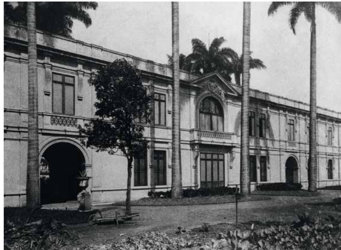
Antiga Biblioteca, prédio construído em 1906 e demolido no final dos anos 1920
