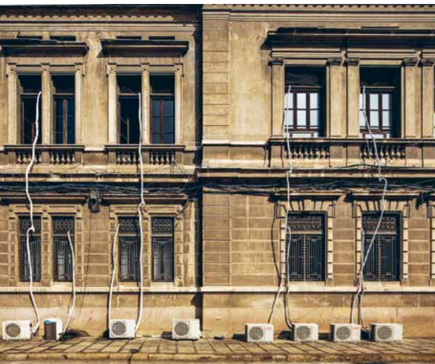
Edifício Sede do Ererio, fachada externa com aparelhos de ar-condicionado
