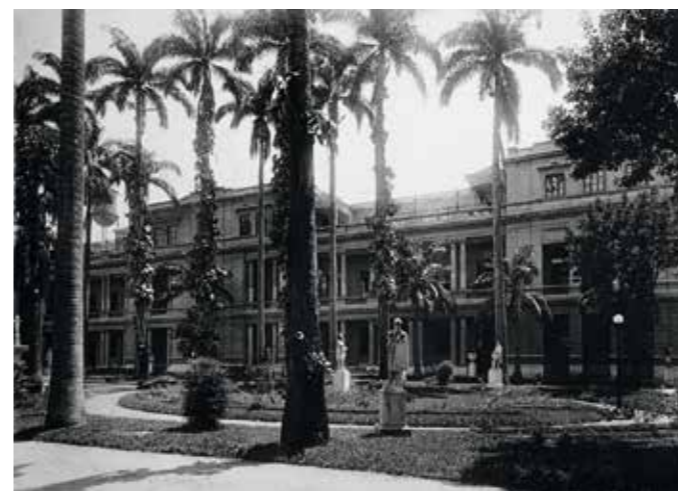
Edifício Novo do Ministério das Relações Exteriores, plantas e foto da fachada, arquiteto Tommaso Bezzi
