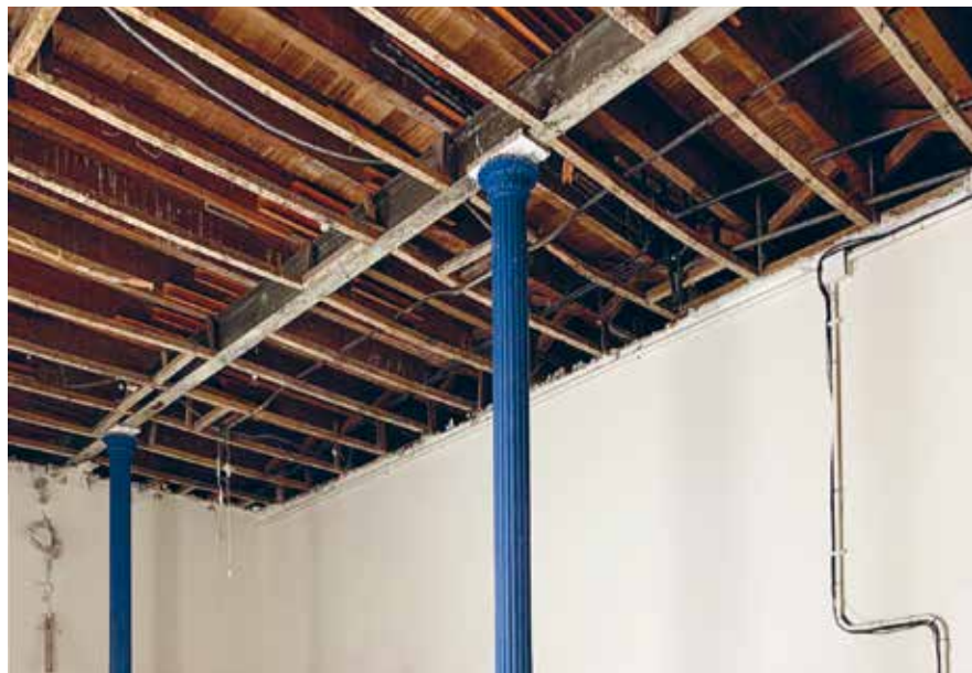
Trabalho de desinfestação, higienização e acondicionamento
