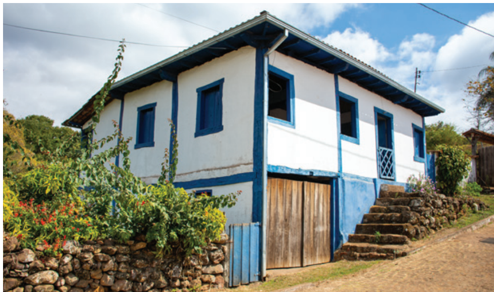
FIG. 84 Sobrado em estrutura autônoma de madeira, Santa Rita Durão. Foto dos autores, 2022.
