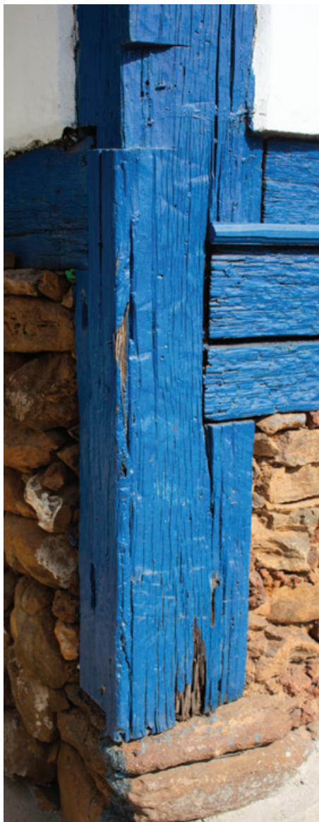
FIG. 58 À esquerda, parte do nabo em fundação pontual de casa térrea com estrutura autônoma de madeira, Cláudio Manoel. Foto dos autores, 2022.
