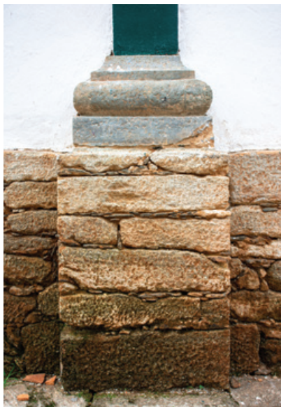
FIG. 71 Acima, exemplo de canjicado em muro de contenção, Furquim. Foto dos autores, 2022.
