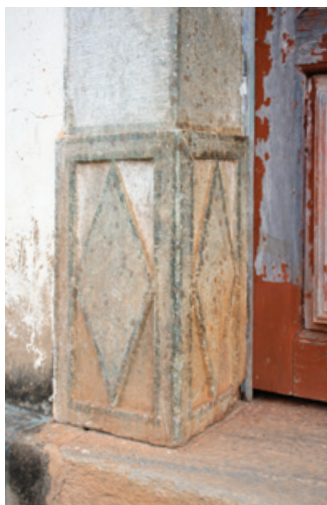
FIG. 77 Acima, base das ombreiras de pedra-sabão das portas da Igreja Matriz de Nossa Senhora da Conceição, de Cachoeira do Brumado. Foto dos autores, 2022.
