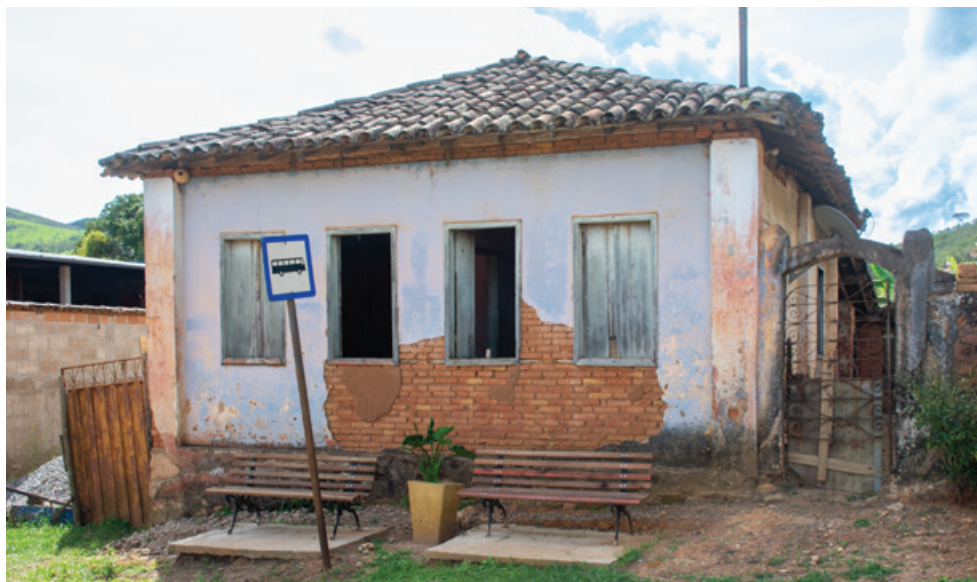
FIG. 81 Casa térrea, Bandeirantes. Foto dos autores, 2022.
