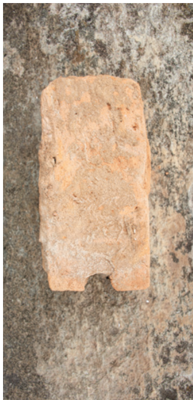
FIG. 105 À esquerda, detalhe de tijolo cerâmico maciço com encaixe para conexão com a face interna do esteio de madeira, Cláudio Manoel. Foto dos autores, 2022.
