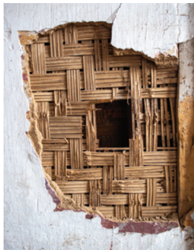
FIG. 96 E FIG. 97 Paredes de estuque na Casa do Conde de Assumar, Mariana - Sede. Foto dos autores, 2022.
