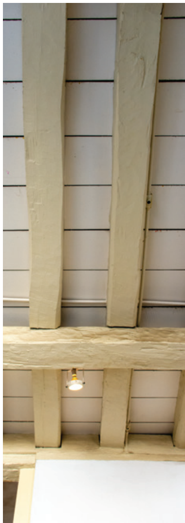
FIG. 119 Vista abaixo do barroteamento que sustenta o piso tabuado do pavimento superior do Museu Arquidiocesano de Arte Sacra, Mariana - Sede. Foto dos autores, 2022.
