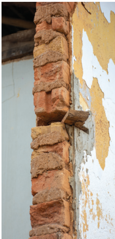
FIG. 105 À esquerda, detalhe de tijolo cerâmico maciço com encaixe para conexão com a face interna do esteio de madeira, Cláudio Manoel. Foto dos autores, 2022.
