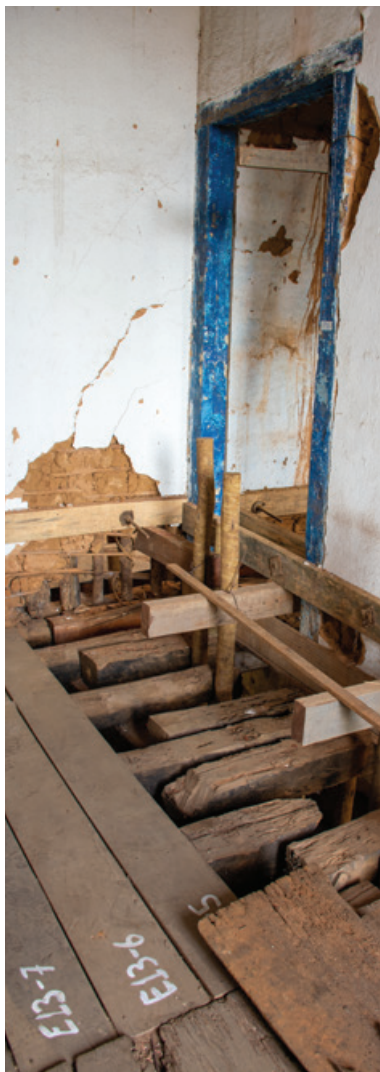
FIG. 119 Vista abaixo do barroteamento que sustenta o piso tabuado do pavimento superior do Museu Arquidiocesano de Arte Sacra, Mariana - Sede. Foto dos autores, 2022.
