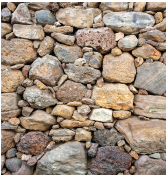
FIG. 71 Acima, exemplo de canjicado em muro de contenção, Furquim. Foto dos autores, 2022.
