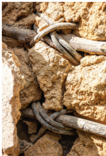
FIG. 94 À esquerda, exemplo de amarração da trama de pau a pique feita com cipó, Furquim. Foto dos autores, 2022.
