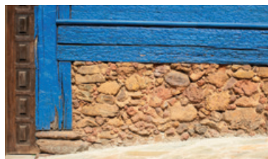
FIG. 61 Acima, alicerce de alvenaria de pedra em casa térrea com paredes de tijolos cerâmicos, Furquim. Foto dos autores, 2022.
