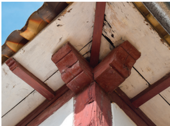
FIG. 54 À esquerda, detalhe de encaixe de viga baldrame em esteio em edificação civil de Mariana - MG. Foto dos autores, 2022.
