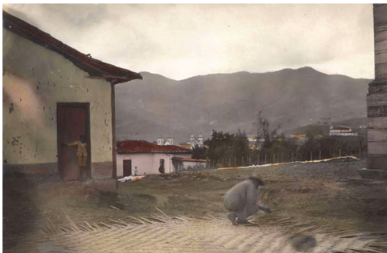
FIG. 158 Fabricação de esteira de taquara para forro de telhado, ao lado da Igreja de Nossa Senhora do Rosário dos Homens Pretos, Mariana – Sede. FERBER, sem data. Portal do Arquivo Público Mineiro.
