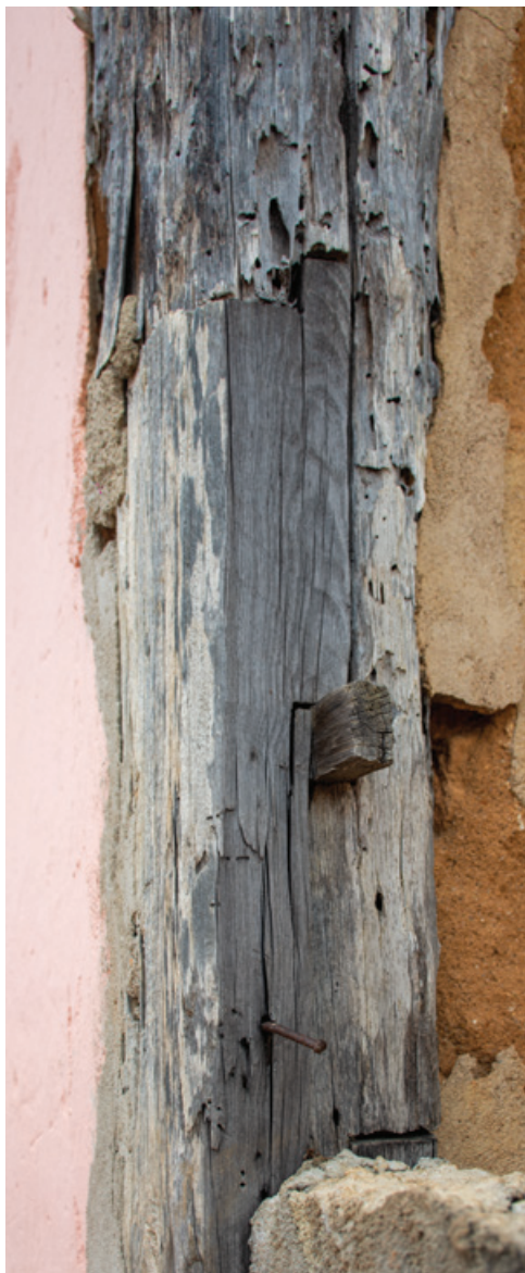
FIG. 87 À esquerda, sambladura de pilar de madeira com sistema de trava na Igreja de Nossa Senhora da Glória do Barro Branco, Padre Viegas. Foto dos autores, 2022.
