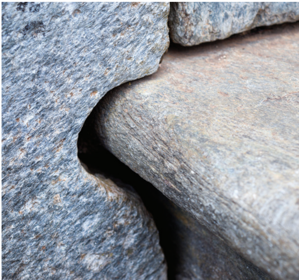
FIG. 167 Detalhe do encaixe do guarda-corpo como degrau da escadaria da Igreja de São Francisco de Assis, Mariana - Sede. Foto dos autores, 2022.
