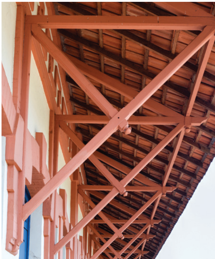
FIG. 155 Mão-francesa do beiral do telhado da antiga estação ferroviária Ribeirão do Carmo, Bandeirantes. Foto dos autores, 2022.
