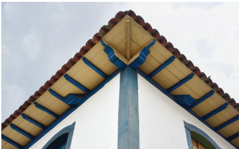
FIG. 85 Acima, trava de canto, peça diagonal que trava e estabiliza na horizontal a estrutura autônoma de madeira, Santa Rita Durão. Foto dos autores, 2022.
