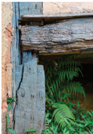
FIG. 54 À esquerda, detalhe de encaixe de viga baldrame em esteio em edificação civil de Mariana - MG. Foto dos autores, 2022.
