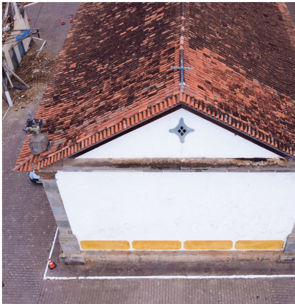
FIG. 146 Exemplo de acabamento da cobertura com telhas assentadas perpendicularmente à inclinação do telhado. Igreja Matriz de Bom Jesus do Monte, Furquim. Foto dos autores, 2022.
