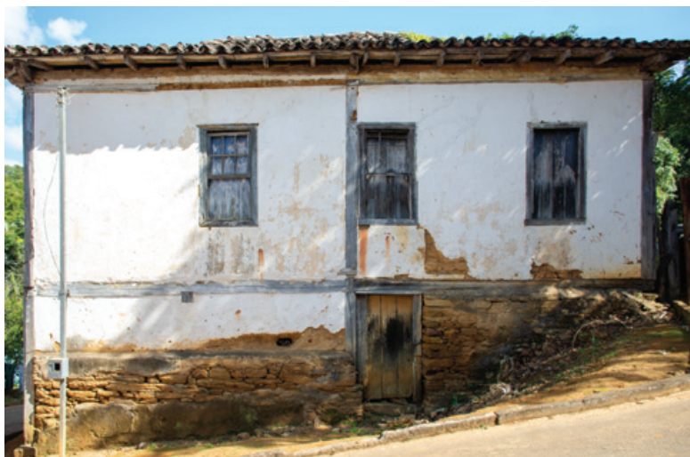
FIG. 89 Sobrado em estrutura mista de alvenaria autoportante de pedra e estrutura autônoma de madeira, Furquim. Foto dos autores, 2022.
