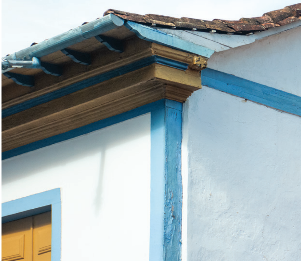
FIG. 138 Exemplo de cobertura estruturada por pontalete em sobrado em Mariana - Sede. Foto dos autores, 2022.
