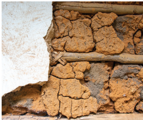
FIG. 94 À esquerda, exemplo de amarração da trama de pau a pique feita com cipó, Furquim. Foto dos autores, 2022.
