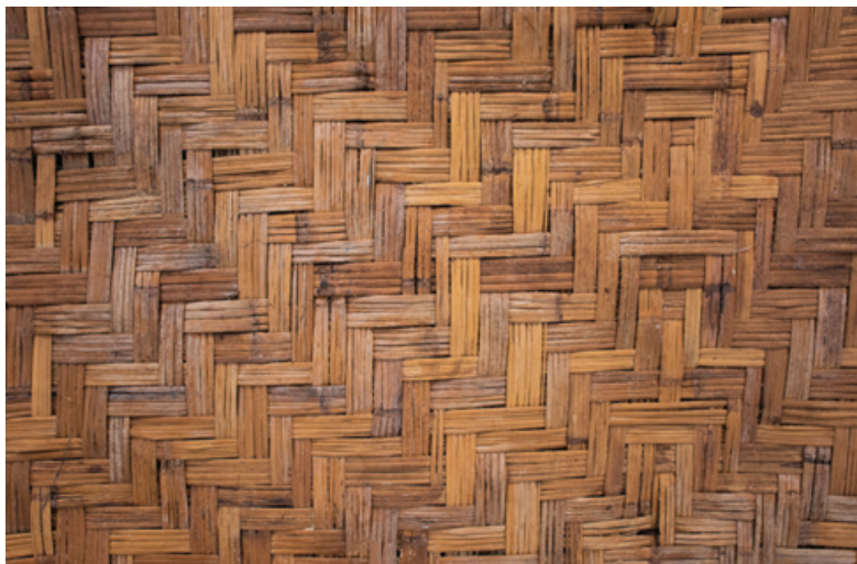
FIG. 159 Forro de esteira de taquara em edificação civil, Santa Rita Durão. Foto dos autores, 2022.
