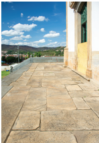
FIG. 111 Piso de pedra lajeado no corredor lateral da Capela de Nossa Senhora do Carmo, Furquim. Foto dos autores, 2022.
