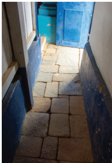
FIG. 111 Piso de pedra lajeado no corredor lateral da Capela de Nossa Senhora do Carmo, Furquim. Foto dos autores, 2022.
