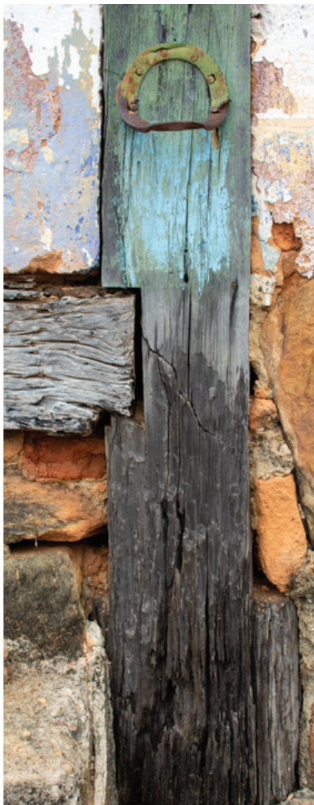
FIG. 58 À esquerda, parte do nabo em fundação pontual de casa térrea com estrutura autônoma de madeira, Cláudio Manoel. Foto dos autores, 2022.
