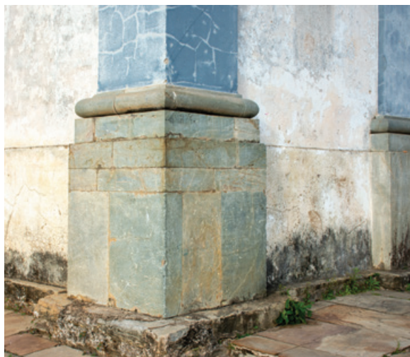
FIG. 77 Acima, base das ombreiras de pedra-sabão das portas da Igreja Matriz de Nossa Senhora da Conceição, de Cachoeira do Brumado. Foto dos autores, 2022.
