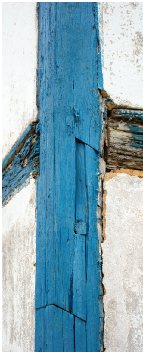
FIG. 87 À esquerda, sambladura de pilar de madeira com sistema de trava na Igreja de Nossa Senhora da Glória do Barro Branco, Padre Viegas. Foto dos autores, 2022.
