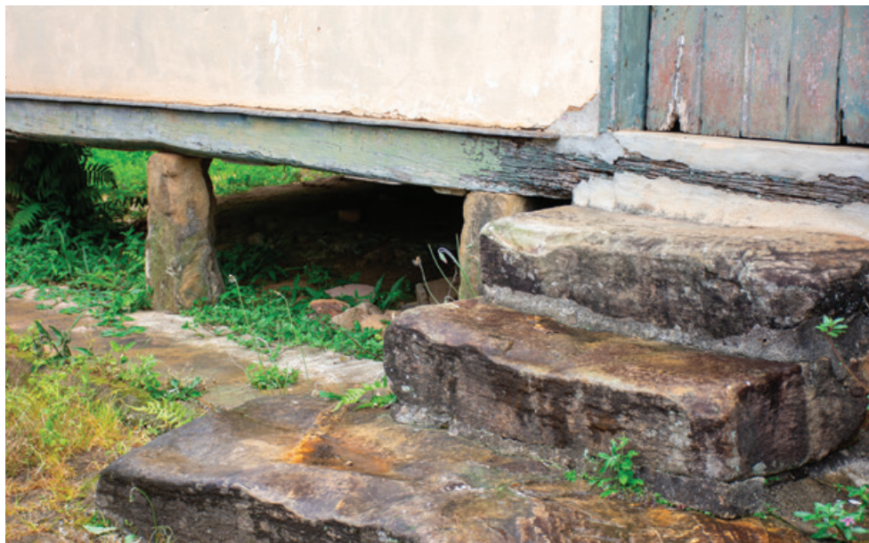
FIG. 60 Burros de pedra, elementos da fundação de casa térrea com estrutura autônoma de madeira, Cláudio Manoel. Foto dos autores, 2022.
