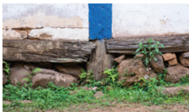
FIG. 61 Acima, alicerce de alvenaria de pedra em casa térrea com paredes de tijolos cerâmicos, Furquim. Foto dos autores, 2022.
