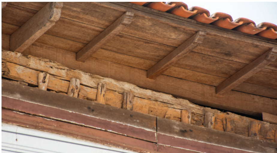
FIG. 93 Exemplo de paus a pique são fixadas lateralmente nos frechais com o uso de pregos, Santa Rita Durão. Foto dos autores, 2022.
