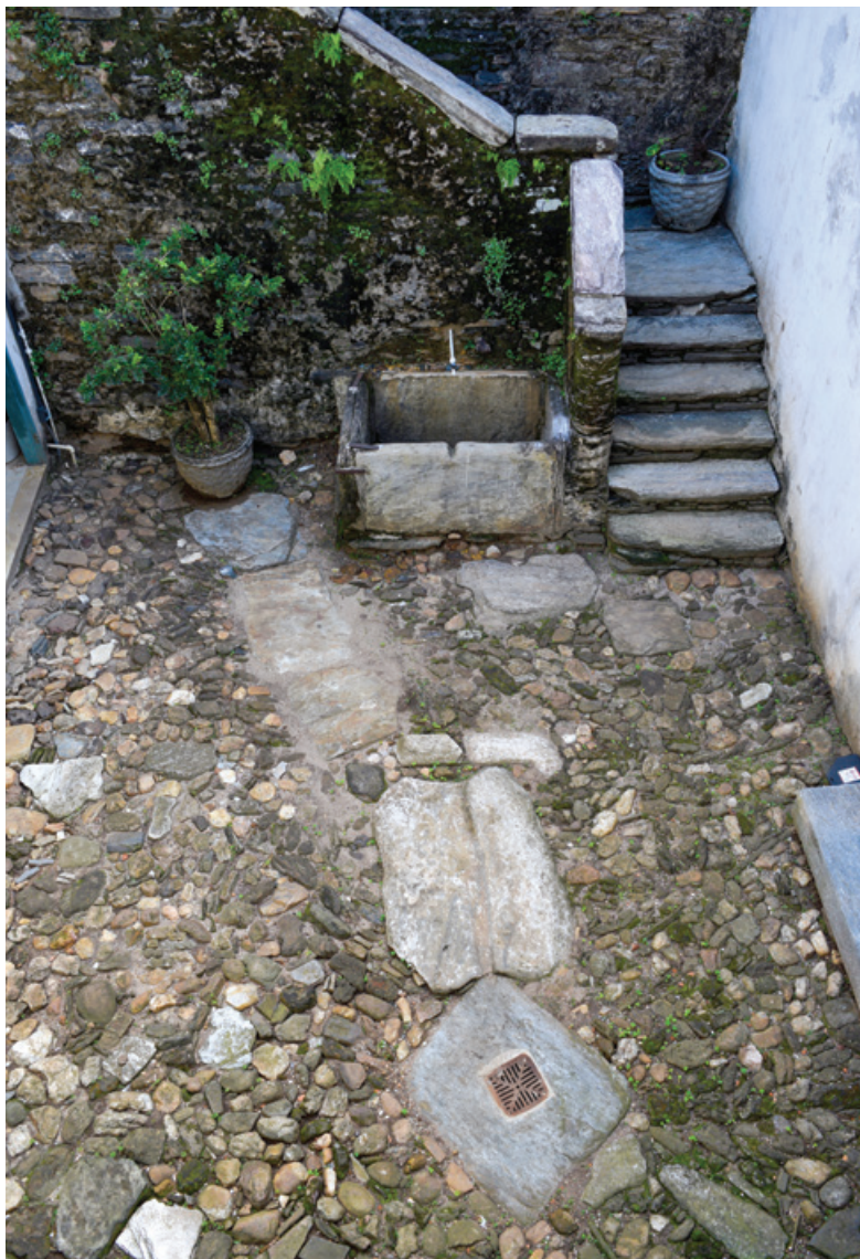
FIG. 187 Tanque de antiga estrutura de abastecimento de água e canaleta de drenagem de pedra do pátio da sede do Centro de Apoio ao Turista, Mariana - Sede. Foto dos autores, 2022.
