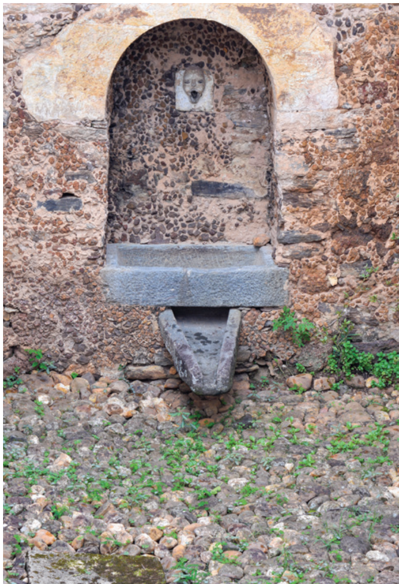
FIG. 186 Bica de antiga estrutura de abastecimento de água e tampa de drenagem de pedra do pátio da Casa Setecentista - Escritório Técnico do IPHAN em Mariana, Sede. Foto dos autores, 2022.
