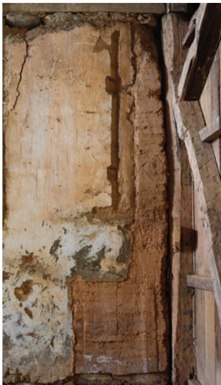
FIG. 82 À esquerda, parede de taipa de pilão da nave da Igreja Matriz de Nossa Senhora da Conceição, Camargos. Foto dos autores, 2023.
