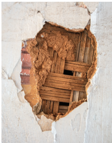
FIG. 96 E FIG. 97 Paredes de estuque na Casa do Conde de Assumar, Mariana - Sede. Foto dos autores, 2022.
