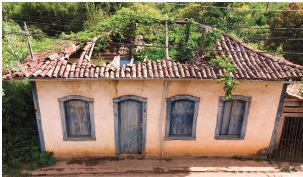
FIG. 135 Acima, telhado em quatro águas em edificação civil de Mariana - MG. Foto dos autores, 2022.
