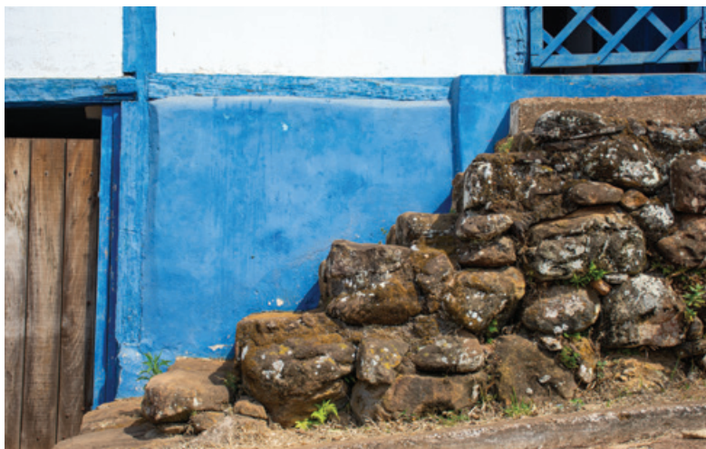
FIG. 172 Escada de alvenaria de pedra em edificação civil. Santa Rita Durão. Foto dos autores, 2022.
