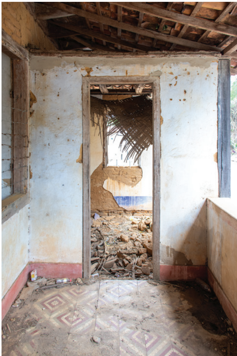
FIG. 123 Piso de ladrilhos hidráulicos em alpendre de casa térrea, Furquim. Foto dos autores, 2022.
