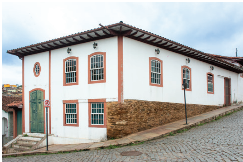
FIG. 90 Acima, sobrado em estrutura mista de alvenaria autoportante de pedra e estrutura autônoma de madeira, Mariana – Sede. Foto dos autores, 2022.
