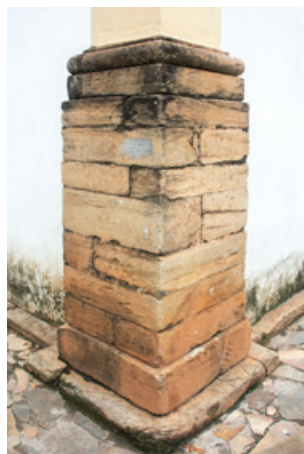
FIG. 63 Acima, embasamento de alvenaria de pedra em casa térrea com estrutura autônoma de madeira, Bandeirantes. Foto dos autores, 2022.
