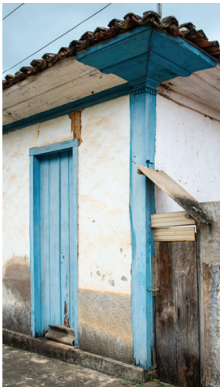
FIG. 82 À esquerda, parede de taipa de pilão da nave da Igreja Matriz de Nossa Senhora da Conceição, Camargos. Foto dos autores, 2023.
