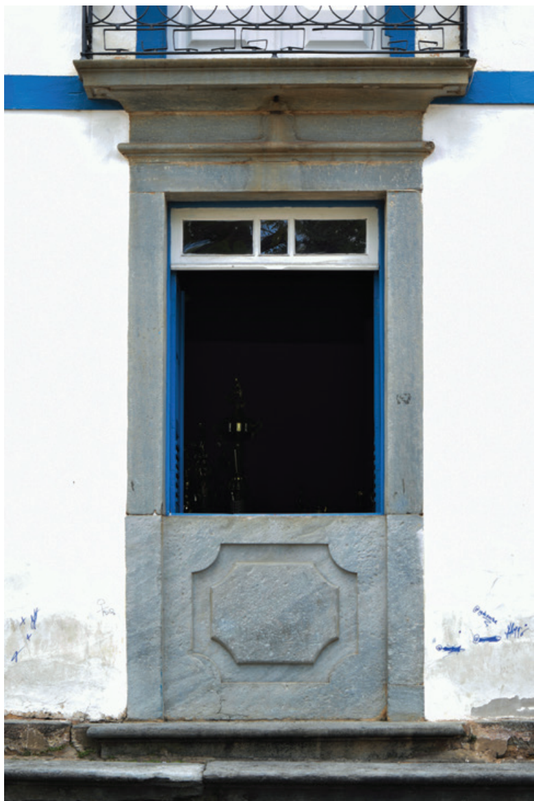
FIG. 126 Janela de peitoril de sobrado situado à Rua Barão de Camargos, Mariana - Sede. Foto dos autores, 2022.
