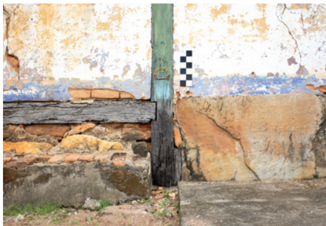
FIG. 63 Acima, embasamento de alvenaria de pedra em casa térrea com estrutura autônoma de madeira, Bandeirantes. Foto dos autores, 2022.
